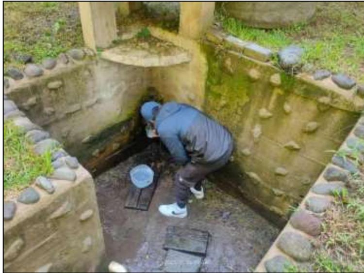
**Figura 3.1 Medición caudal método volumétrico**
