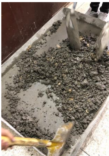
Figura 21: Proceso de mezcla de hormigón con fibras
