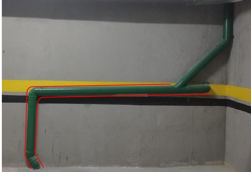
Figura 6. Conexión de tubería externa con pozos
