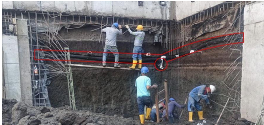
Figura 4. Colocación de tuberías de subdrenaje en el subsuelo 4 de Engadí
