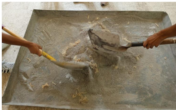
Figura 14. Preparación de Mezcla
