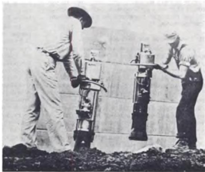
Figura 3. Compactación por impacto
