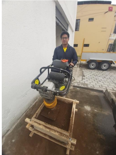
Figura 32. Proceso de compactación
