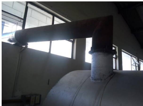
Figura 13. Chimenea del Incinerador. (Fuente: Propia)
