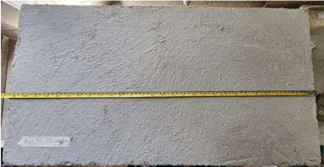
PLACA 03-CF-1%. NO MUESTRA AGRIETAMIENTO
