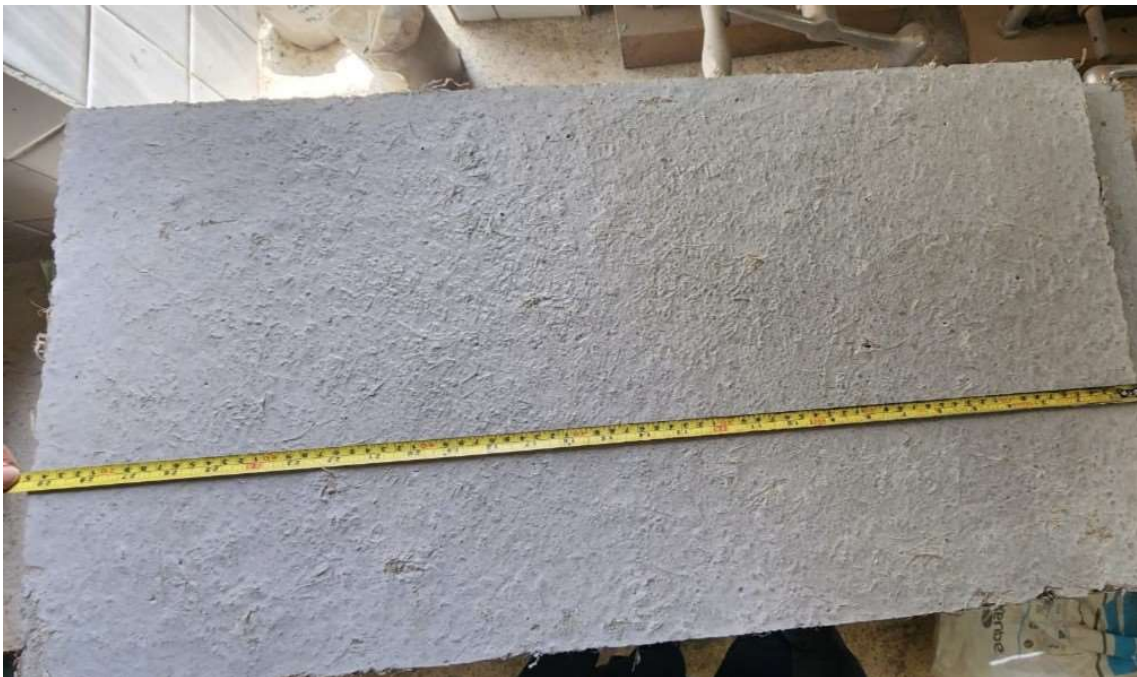
PLACA 06-CF-1%. NO MUESTRA AGRIETAMIENTO
