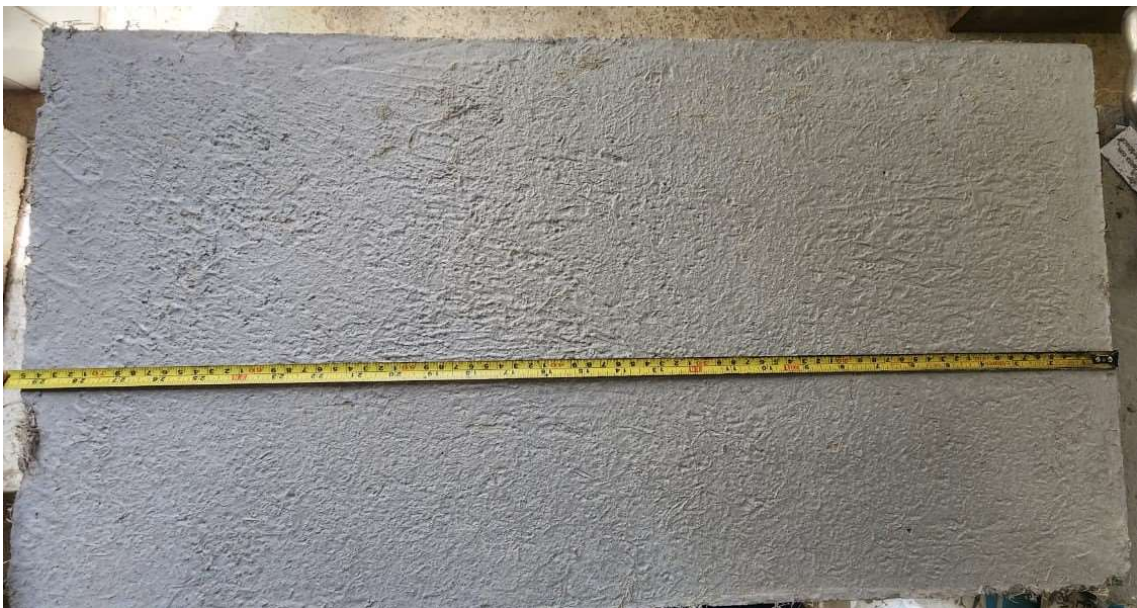
PLACA 04-CF-1%. NO MUESTRA AGRIETAMIENTO
