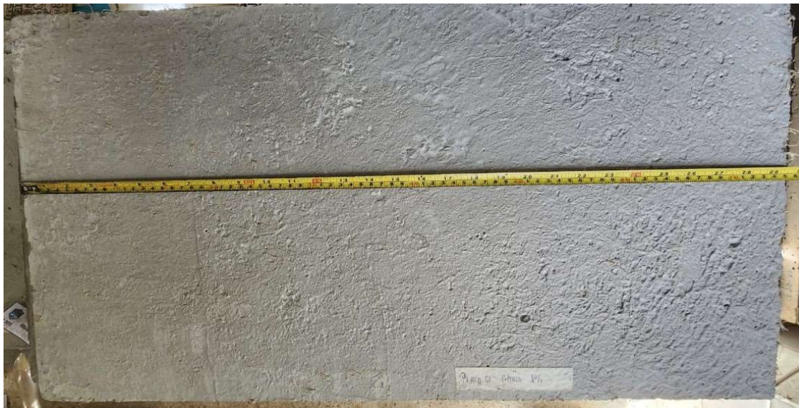
PLACA 01-CF-1%. NO MUESTRA AGRIETAMIENTO
