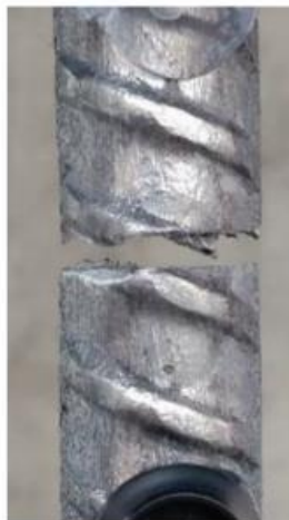
Figura 1.8 Detalle falla frágil
