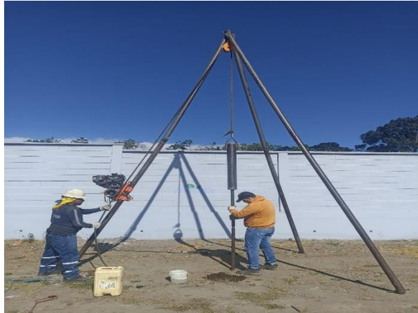
Figura 33. Punto de muestreo antes del cementerio de Aloasí. Tomada por: Quishpe, B (2023).
