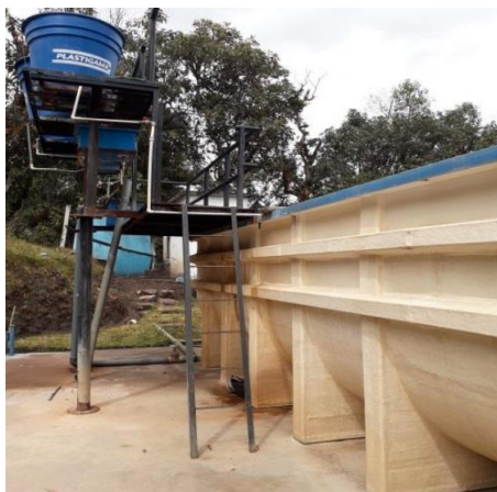
Figura 1. Infraestructura de PTAP de “Rumipamba”
