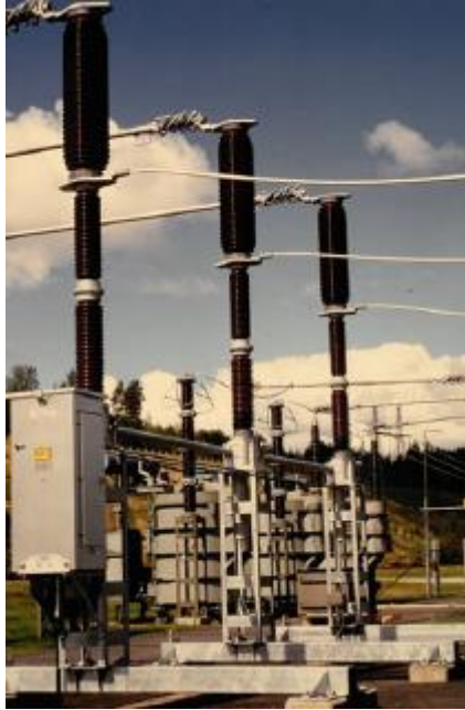
Figura 1.7: Disyuntor tipo puffer de doble y simple apertura 245 kV marca ABB[1]
