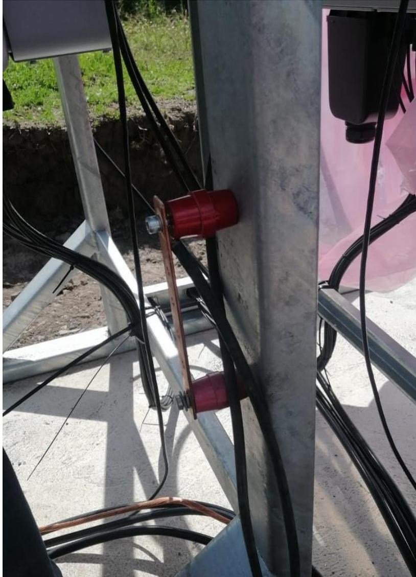
**Figura 3.14.** Barra de cobre en la estructura de soporte para conexión de puesta a tierra de cada inversor
