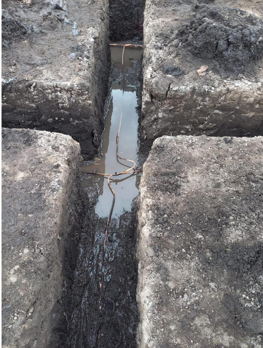
**Figura 3.10.** Malla de puesta a tierra del centro de transformación y conexión cadweld entre conductores y varillas
