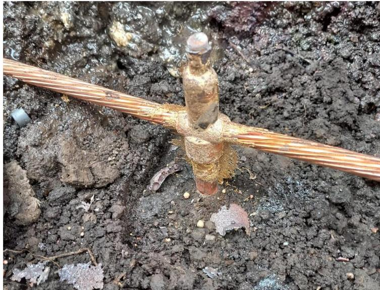
**Figura 3.9.** Varilla copperweld de acero con Cu recubierto de alta camada de 1,8 m de longitud
