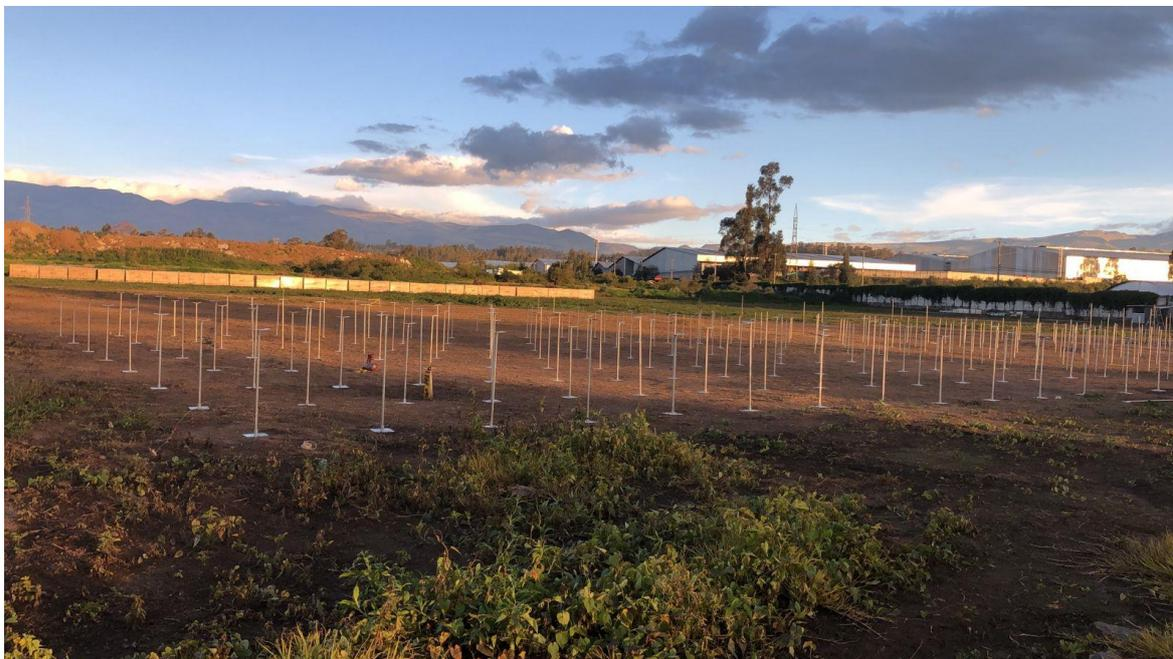
**Figura 3.11.** Instalación de estructuras metálicas ancladas al piso
