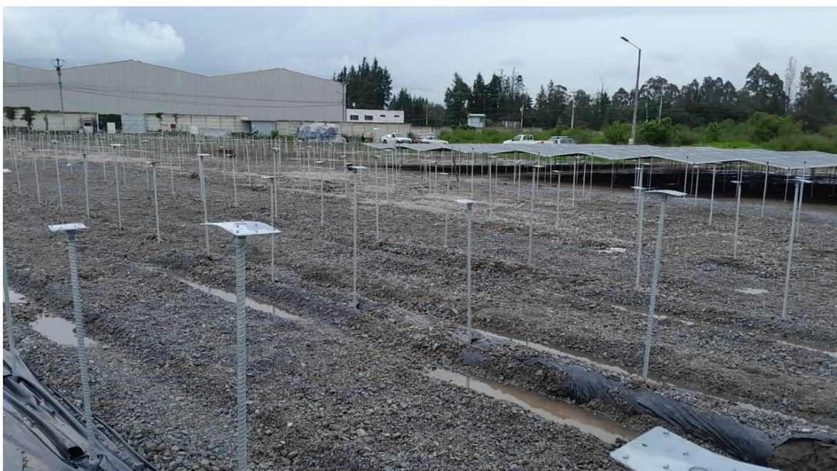
**Figura 3.12.** Colocación de una fina capa de grava a lo largo del área de paneles
