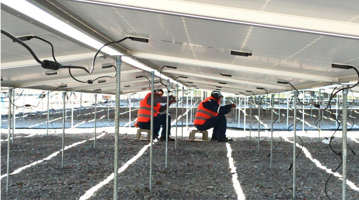
**Figura 3.13.** Conexión y unión de los paneles sobre las estructuras metálicas
