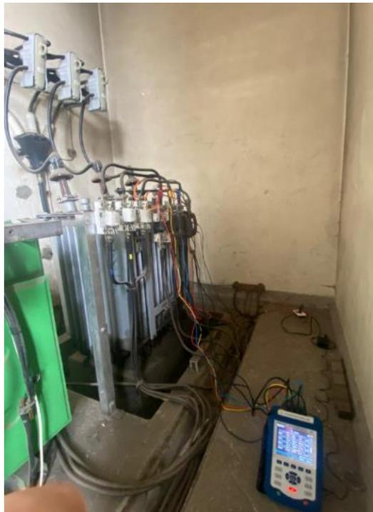
**Figura 13.** Recolección de mediciones en el transformador (Facultad de Mecánica)
