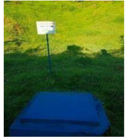
Figura 3: Galería de Infiltración de la JAAPT
