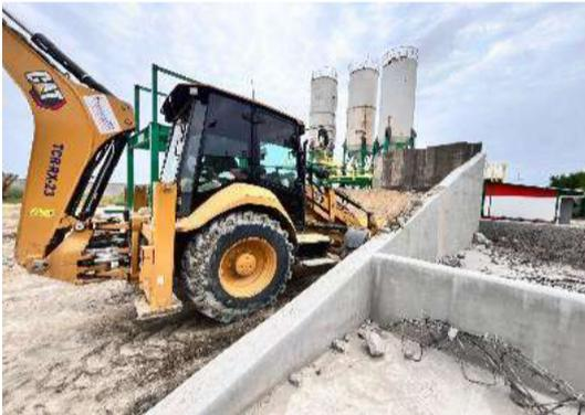
Foto1. Excavación relleno rampa existente
