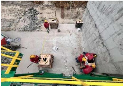
Foto1. Encofrado columnas dosificadora
