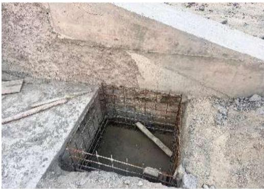
Foto1. Fundición piso buzón eléctrico
