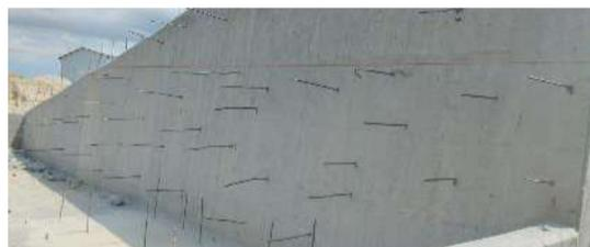
Foto2. Chicoteado para muro de rampa
