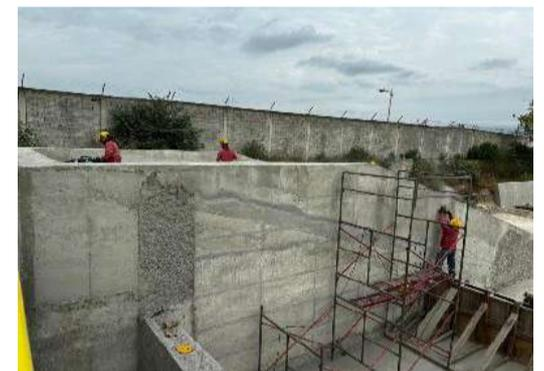
Foto3. Corrección fallas muro
