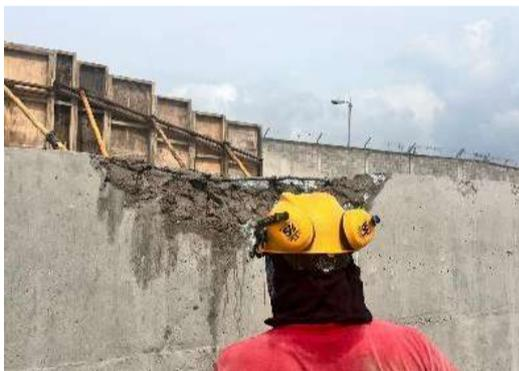
Foto1. Corrección de fallas en muros
