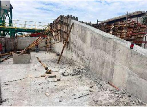
Foto1. Desencofrado muro
