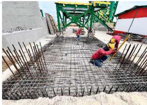
Foto2. Armado acero cimentación dosificadora
