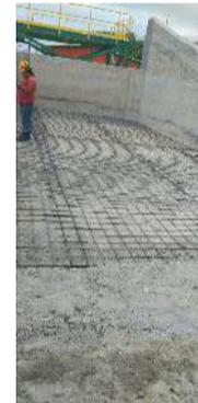
Foto3. Malla de acero para losa cubeto
