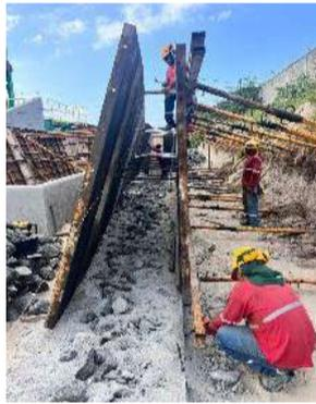
Foto1. Encofrado vertical muro rampa
