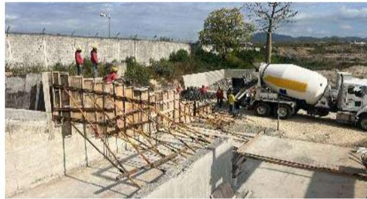
Foto2. Fundición 2da etapa muro
