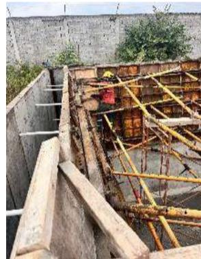
Foto2. Encofrado vertical muro rampa
