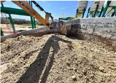
Foto1. Excavación de relleno rampa existente
