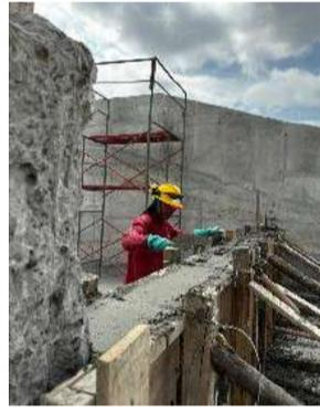
Foto2. Fundición muro cubeto aditivos
