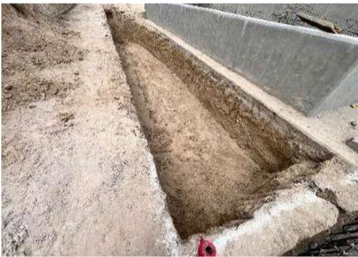
Foto1. Excavación cimentación muro
