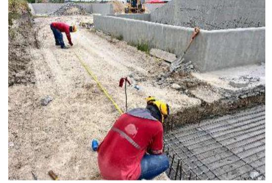
Foto3. Replanteo cimentación muro rampa
