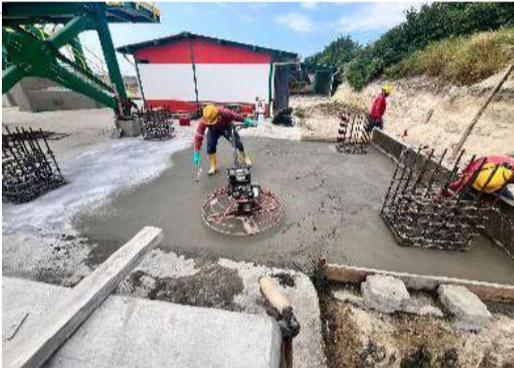
Foto1. Hormigonado cimentación dosificadora
