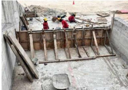
Foto2. Encofrado muro cubeto aditivos
