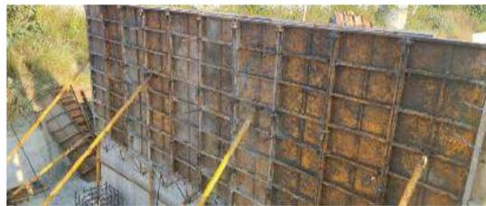
Foto2. Encofrado vertical de muro rampa
