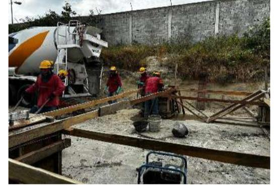
Foto3. Fundición columnas dosificadora
