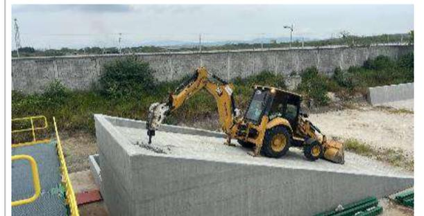
Foto3. Demolición rampa existente
