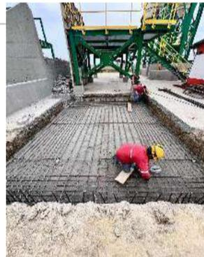
Foto2. Armado acero cimentación dosificadora
