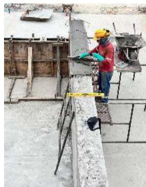
Foto2. Corrección fillos de muros
