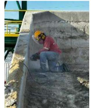
Foto3. Corte de junta en rampa existente
