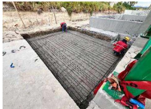
Foto2. Armado acero de refuerzo cimentación dosificadora
