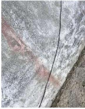
Foto1. Corte de juntas en losa
