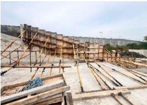
Foto1. Encofrado vertical muro rampa
