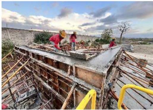
Foto2. Fundición última etapa muro rampa
