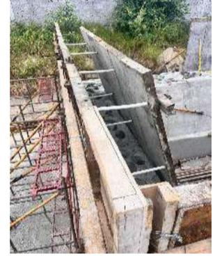
Foto3. Encofrado vertical muro rampa
