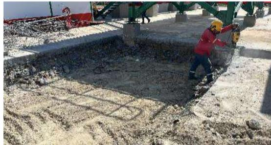
Foto2. Excavación y perfilado cimentación dosificadora
