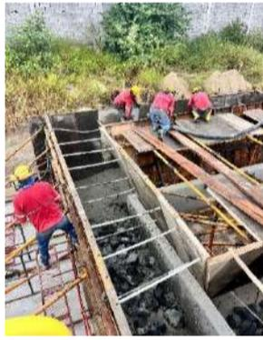
Foto1. Fundición 1ra etapa muro
