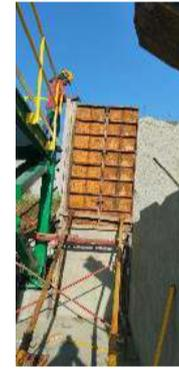
Foto3. Encofrado vertical de muro rampa
