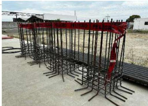
Foto2. Acero de refuerzo columns dosificadora
