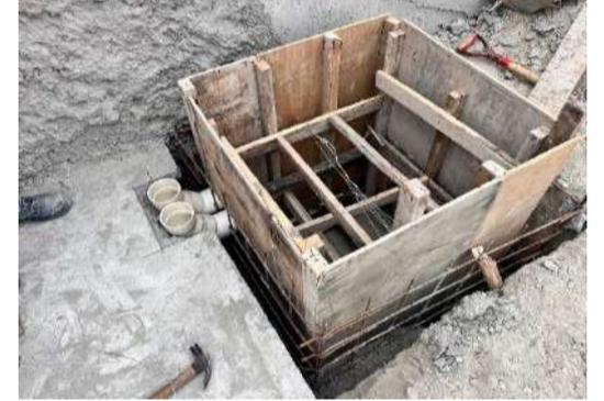
Foto3. Encofrado buzón eléctrico
