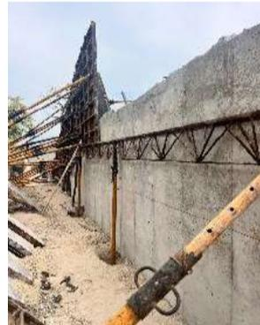
Foto2. Encofrado vertical muro rampa
