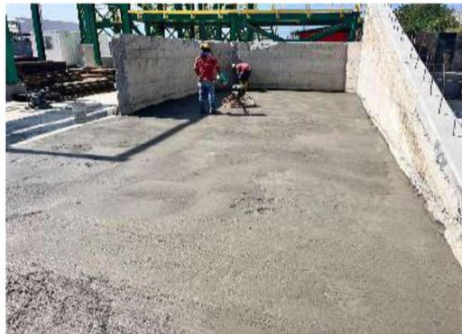
Foto2. Hormigonado losa cubeto
