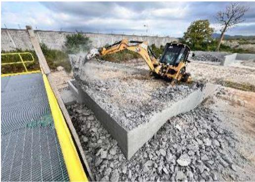
Foto1. Demolición rampa existente
