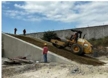
Foto1. Relleno y compactación de Rampa Dosificadora
