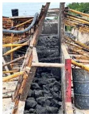
Foto2. Fundición 1ra etapa muro
