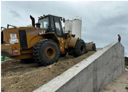
Foto1. Relleno rampa dosificadora
