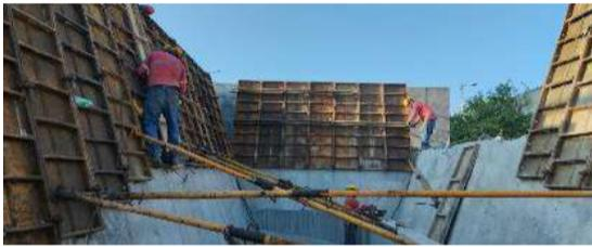
Foto1. Encofrado vertical de muro rampa
