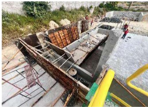
Foto2. Encofrado vertical muro rampa
