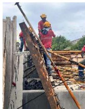
Foto2. Encofrado vertical muro rampa
