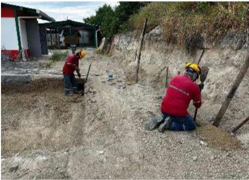
Foto1. Nivelación y replanteo cimentación
