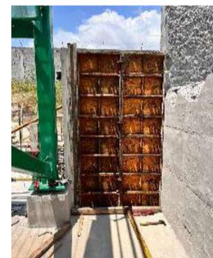
Foto3. Encofrado muro rampa dosificadora
