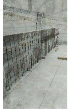
Foto3. Encofrado y acero muro cubeto aditivos
