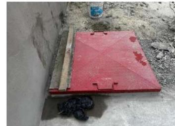
Foto3. Desencofrado buzón eléctrico
