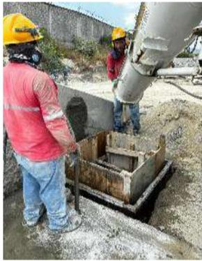
Foto1. Fundición buzón eléctrico
