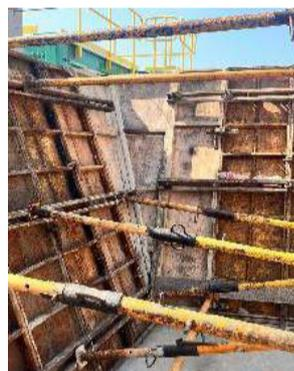
Foto2. Encofrado vertical muro rampa
