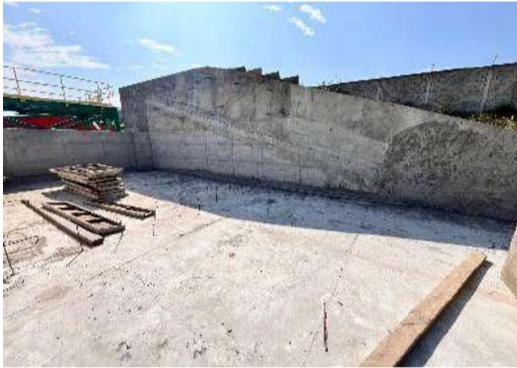
Foto1. Desencofrado muro rampa
