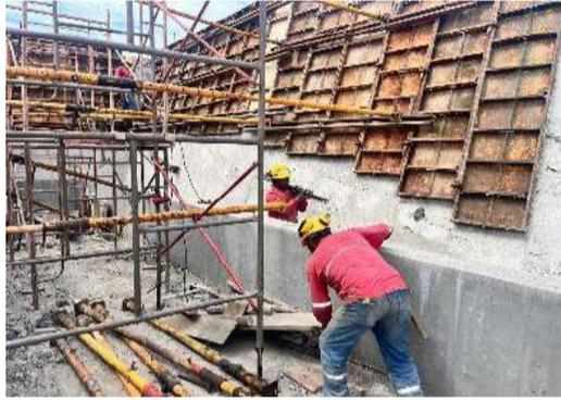
Foto2. Encofrado vertical muro rampa
