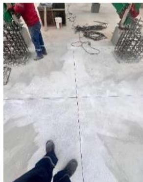
Foto2. Corte de juntas en cimentación
