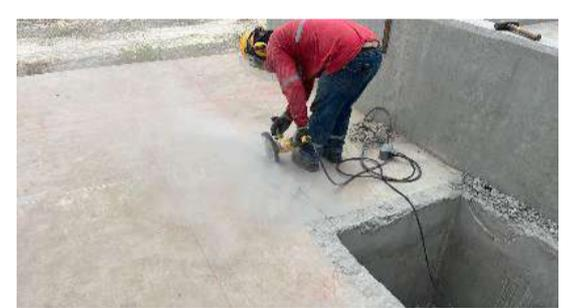
Foto3. Corte de losa para cimentación
