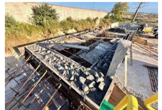
Foto3. Fundición 1ra etapa muro
