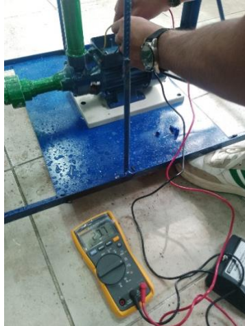
Figura 2.9. Medición en ohmios del devanado secundario o de arranque
