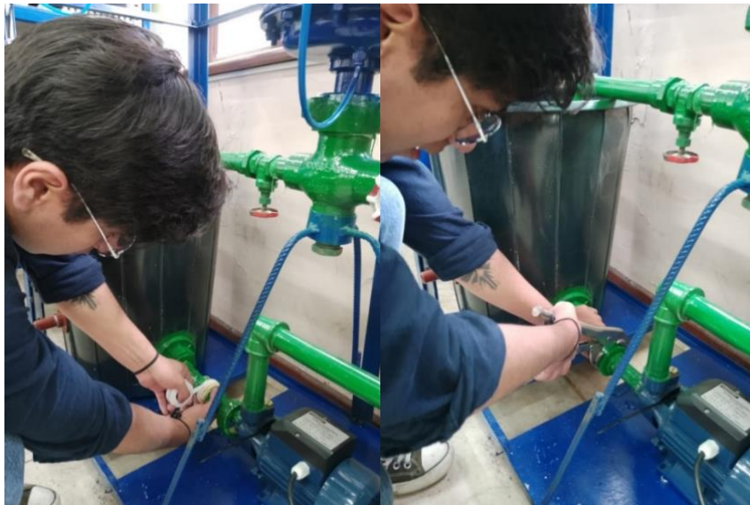
Figura 2.14. Colocación de la cinta teflón y ajuste de la tubería
