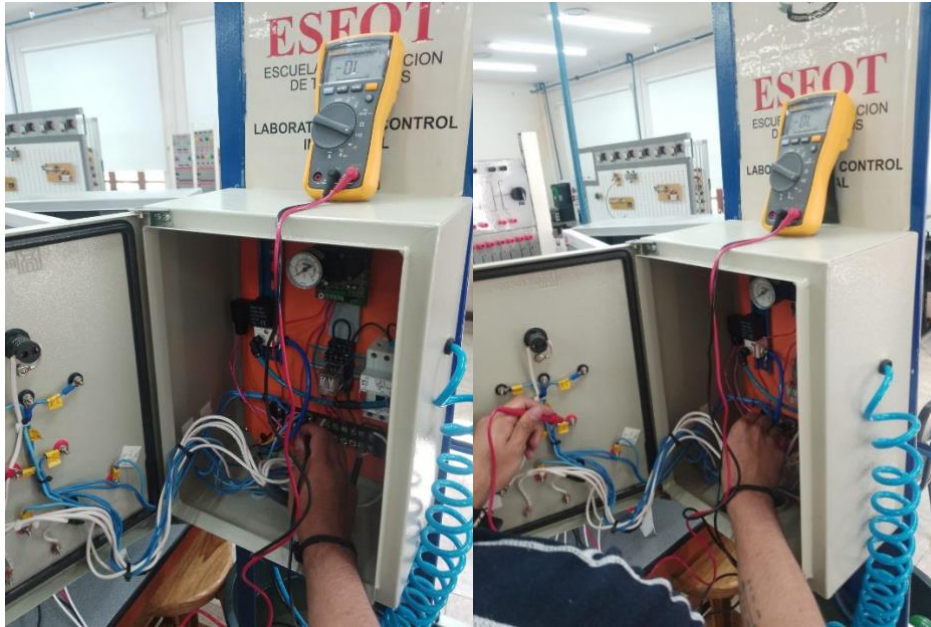
Figura 3.2. Prueba de conductividad en la bomba y electroválvula
