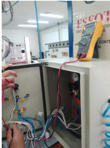
Figura 2.5. Comprobación de los cables
