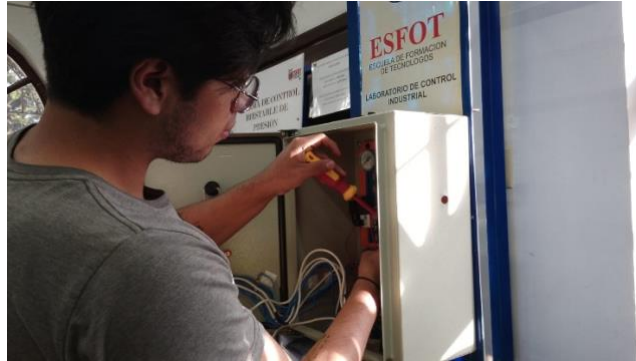
Figura 2.7. Revisión de protecciones eléctricas
