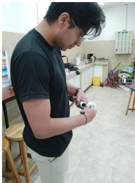
Figura 2.4. Colocación de teflón en las tuberías
