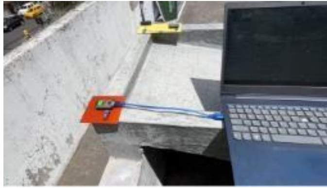
Figura 3.42 Medición de radiación UV (Niveles Altos)
