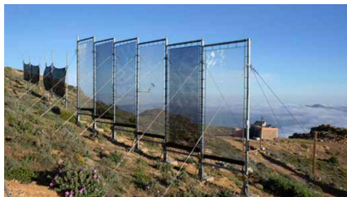
Figura 4. Método Pasivo: Colector de Neblina [6].
