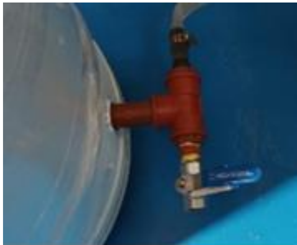
Figura 23. Uniones para distribución de agua. [Fuente propia]
