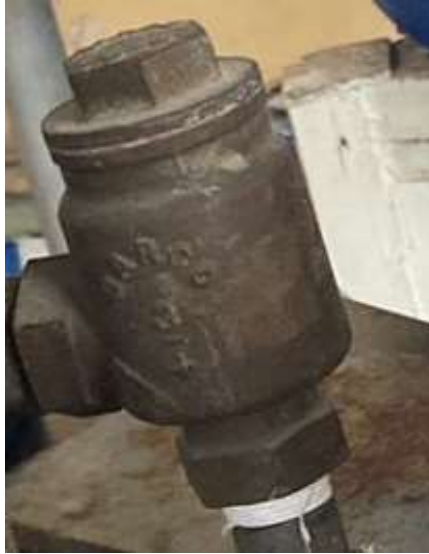
Figura 2.9. Trampa de vapor termostática bimetalica SpiraxSarco.
