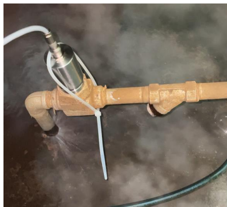
Figura 1.6. Fotografía de trampa descargando a la atmósfera.
