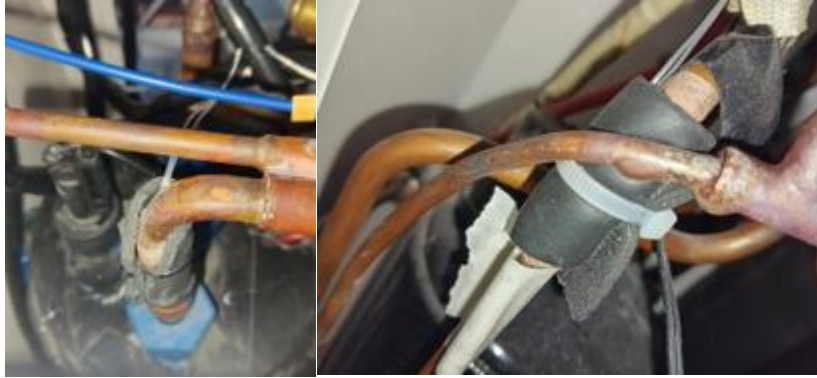
Figura 17. Instalación de los sensores PT100 Fuente: Autor
