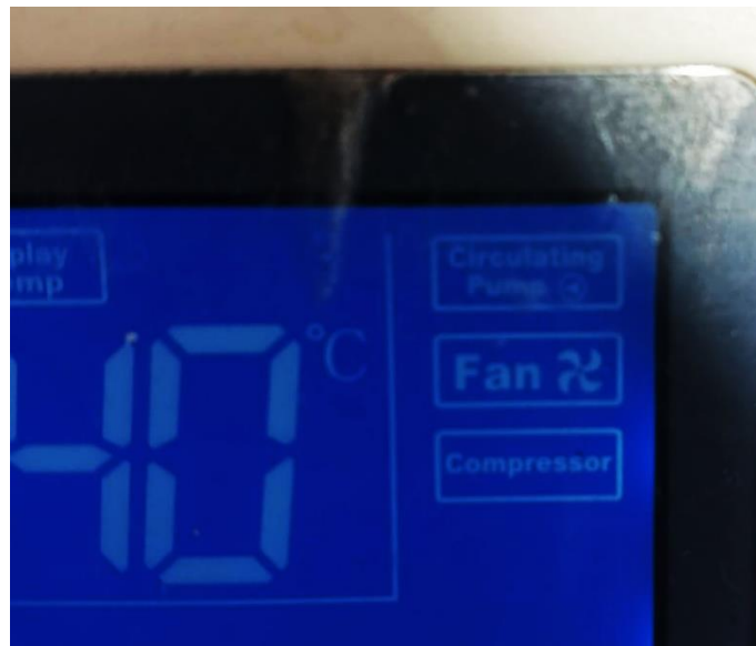
Figura 15. Elementos funcionando en simultaneidad
