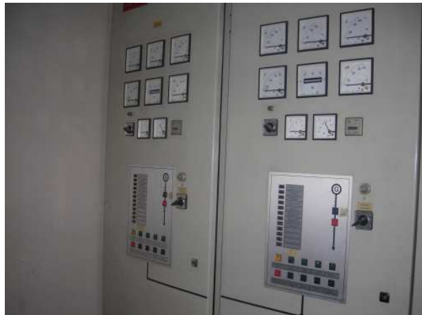
Figura 2.10 Computadoras para el control del generador
