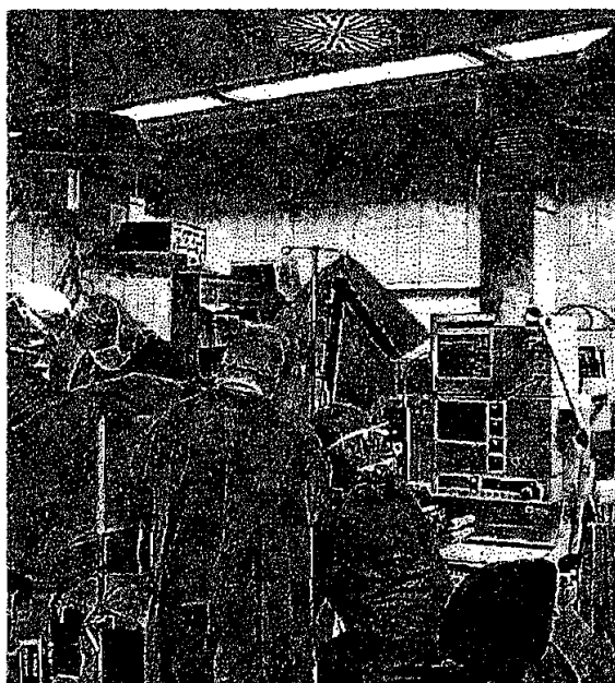
Figura 3.1.3.c. Areas de trabajo típicas con equipamiento y alimentaciones centralizadas incorporadas de un quirófano.
