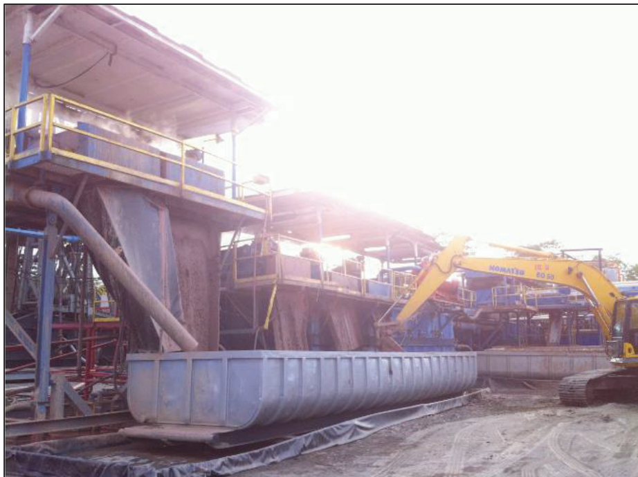
FIGURA 2.41 UNIDAD DE DEWATERING EN OPERACIONES
