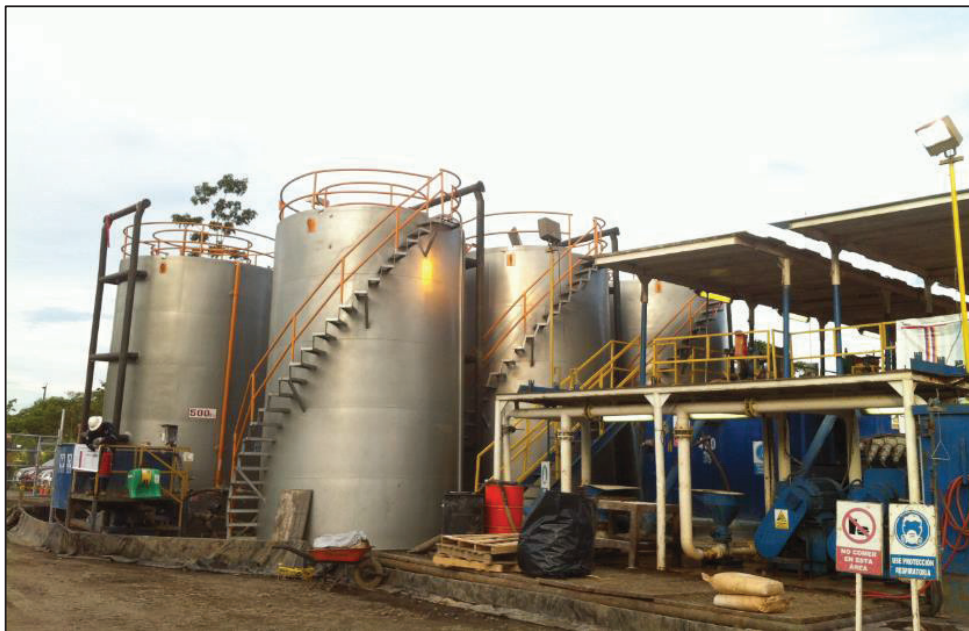
FIGURA 3.5 DISPOSICIÓN DE TANQUES VERTICALES Y UNIDAD DE TRATAMIENTO DE AGUAS
