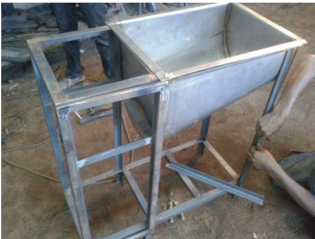
Figura 3.5 Fabricación de la Estructura Soporte.
