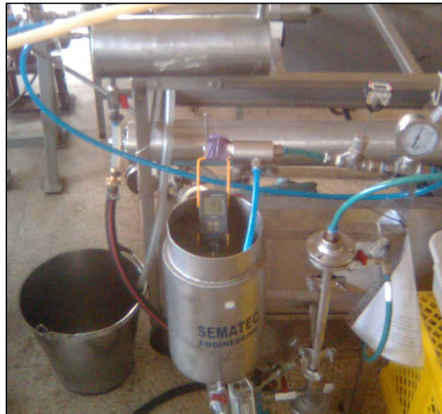
Figura AV.2. Fotografía del equipo de ósmosis inversa Micro 240
