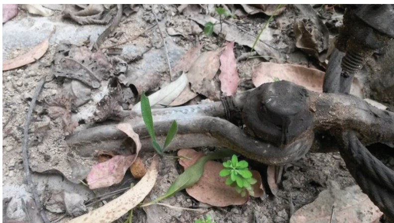
Figura 4.35 Bloque de anclaje de llegada ruta 2 Fuente: propia
