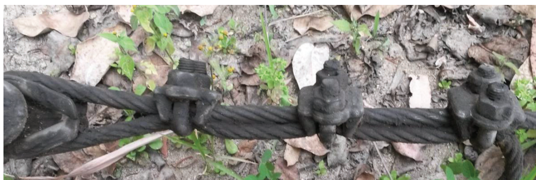
Figura 4.23 Abrazaderas anclaje de llegada Fuente: propia
