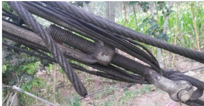
Figura 4.28 Tensor anclaje de salida ruta 1 Fuente: propia
