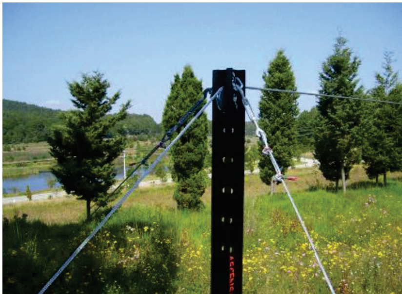
Figura 1.19 Columna de acero en un sistema canopy
