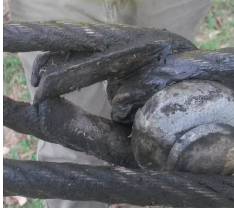
Figura 4.24 Guardacabos anclaje de salida ruta 1 Fuente: propia
