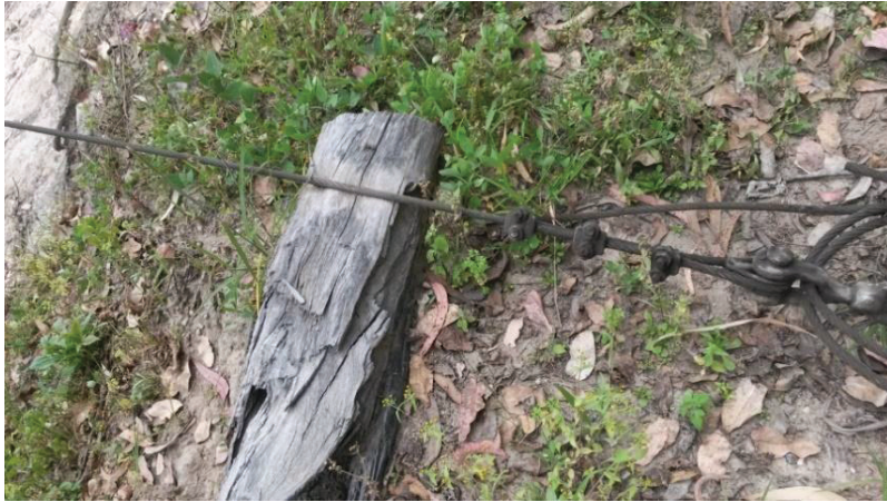
Figura 4.15 Anclaje del punto de llegada de la ruta 2 Fuente: propia
