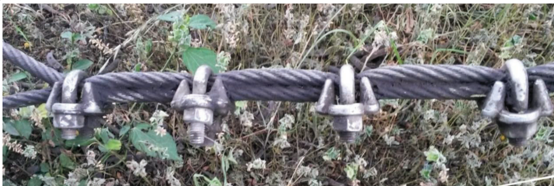
Figura 4.22 Abrazaderas anclaje de salida Fuente: propia
