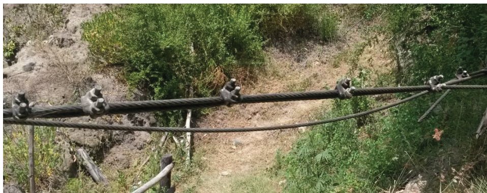
Figura 4.21 Abrazaderas anclaje de llegada Fuente: propia
