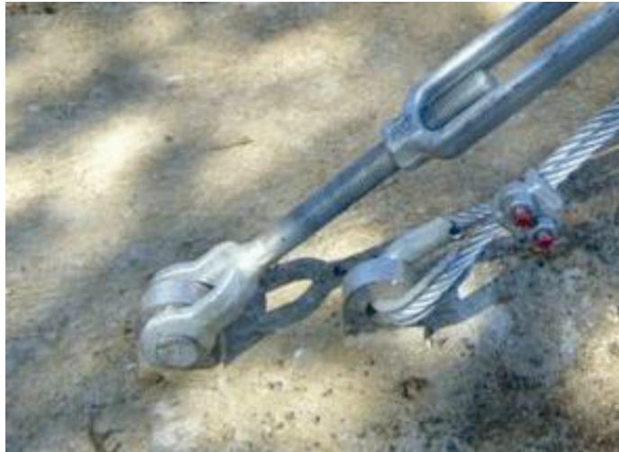
Figura 1.20 Anclaje cimentado
