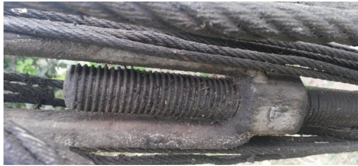
Figura 4.27 Tensor anclaje de salida ruta 1 Fuente: propia
