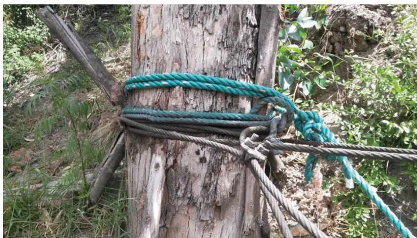
Figura 4.10 Anclaje de llegada de la ruta 1 Fuente: propia
