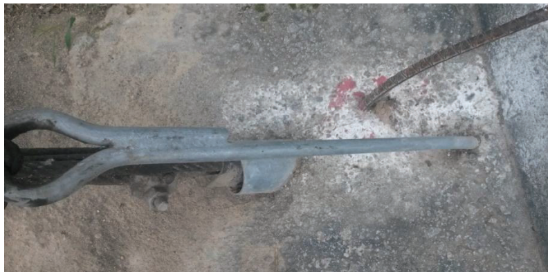
Figura 4.34 Bloque de anclaje de salida ruta 1 Fuente: propia
