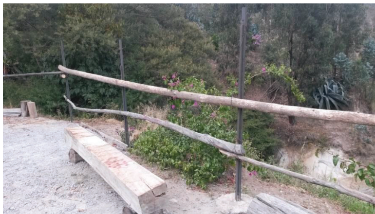
Figura 4.55 Barandillas en el emplazamiento de salida Fuente: propia
