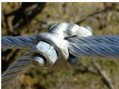
Figura 1.14 Sujeción de cables
