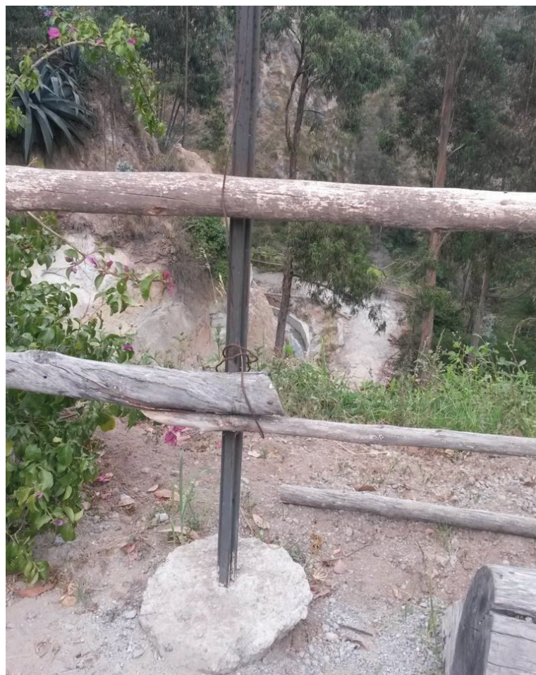
Figura 4.56 Barandillas en el emplazamiento de salida Fuente: propia
