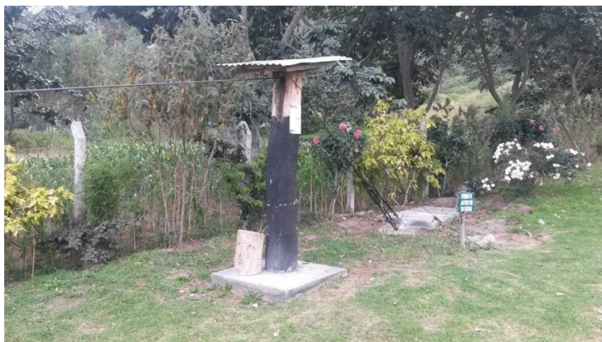
Figura 4.9 Anclaje de partida de la ruta 1 Fuente: propia
