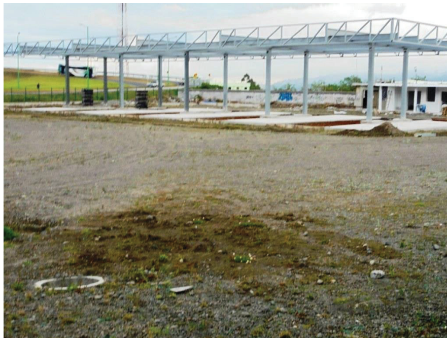
Fotografía 8. Construcción Estación de servicio Mejía, PETROECUADOR, Machachi
