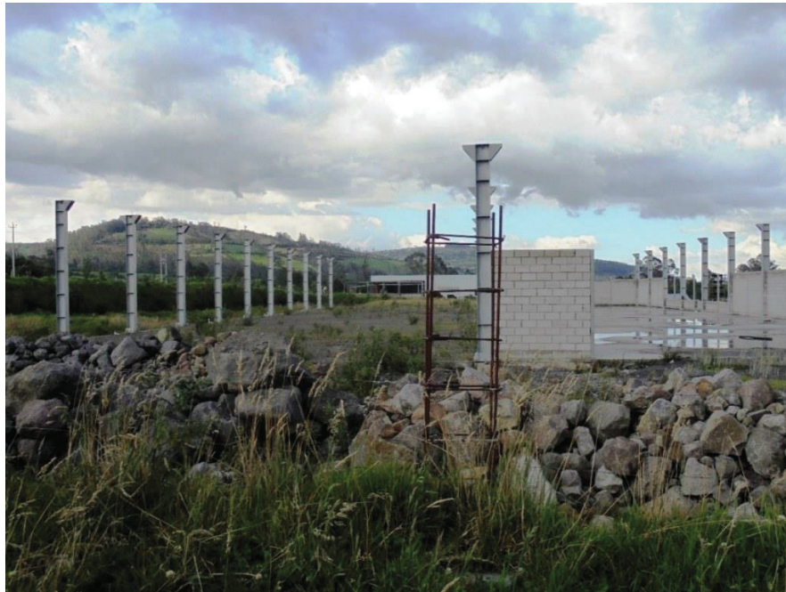
Fotografía 6. Construcción textil Lumontex, Tambillo, sector Miraflores
