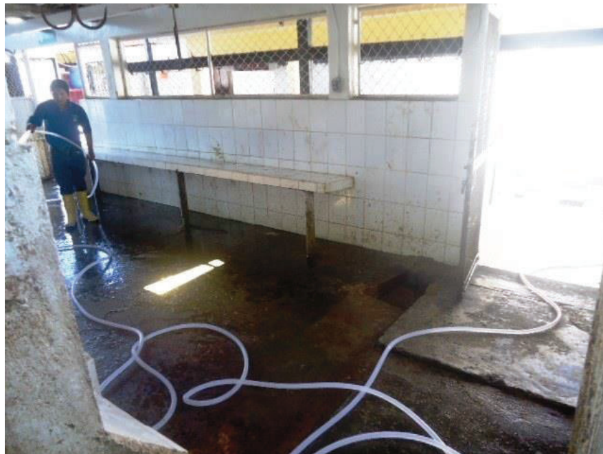
Fotografía 4. Aguas de limpieza de las instalaciones del camal Municipal
