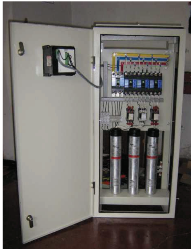
Figura 3.10. Montaje de elementos
