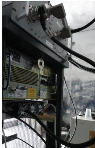
**Figura 51** – Conexión del transmisor al filtro de doble cavidad.
