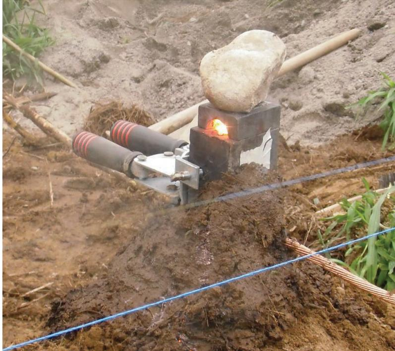
**Figura 42** – Ignición de la pólvora en el molde de grafito.
