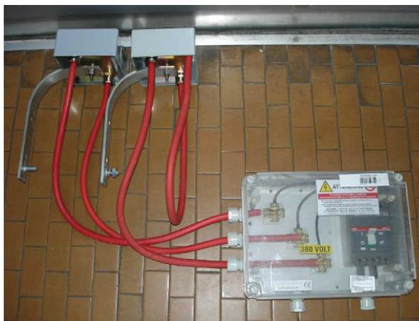
**Figura 35** – Instalación de Breaker térmico
