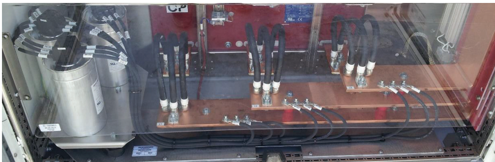
Figura 2. 33 Ejemplo de filtro en el lado de AC.
