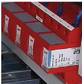
Figura 5. 8 Ejemplo descargador de sobrevoltajes.
