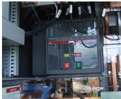
Figura 5. 11 Interruptor de potencia de DC.
