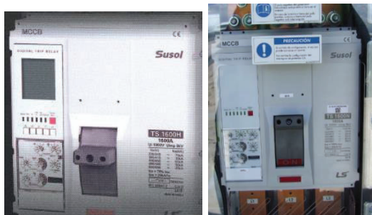
Figura 5. 15 Interruptor automático de potencia de AC sin la opción TEST.
