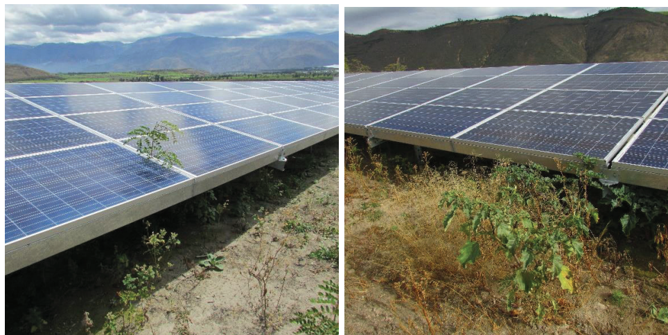
Figura 3. 37 Vegetación o maleza en un parque fotovoltaico.
