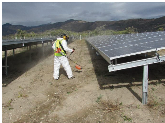
Figura 3. 40 Desbroce del terreno.
