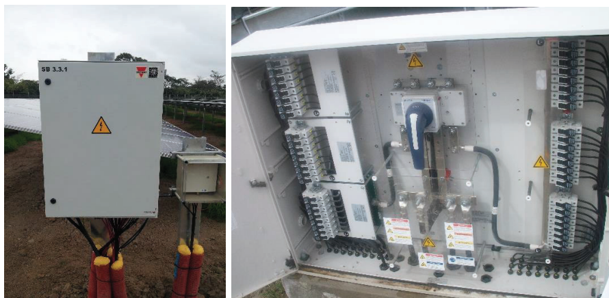
Figura 2. 24 Estructura externa e interna de un equipo de conexión de arreglos de paneles fotovoltaicos o strings. [19]
