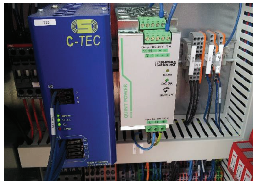
Figura 5. 27 Ejemplo de ubicación del equipo de suministro de energía continua y sin interrupciones al inversor.
