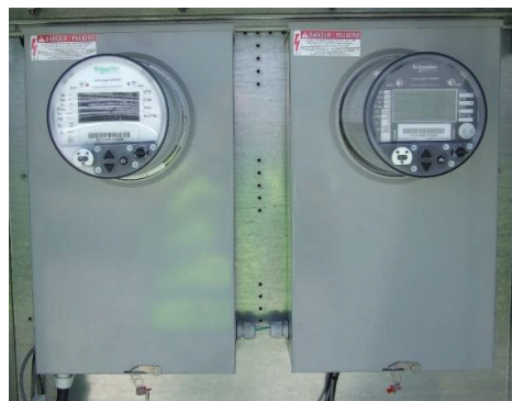
Figura 2. 40 Ejemplo de Medidor Principal y de Respaldo.
