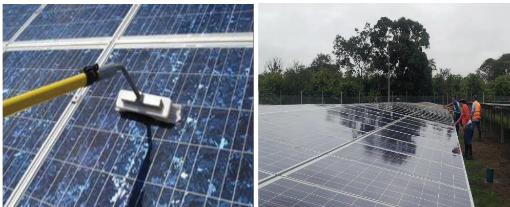
Figura 3. 43 Limpieza manual de paneles fotovoltaicos. [52]
