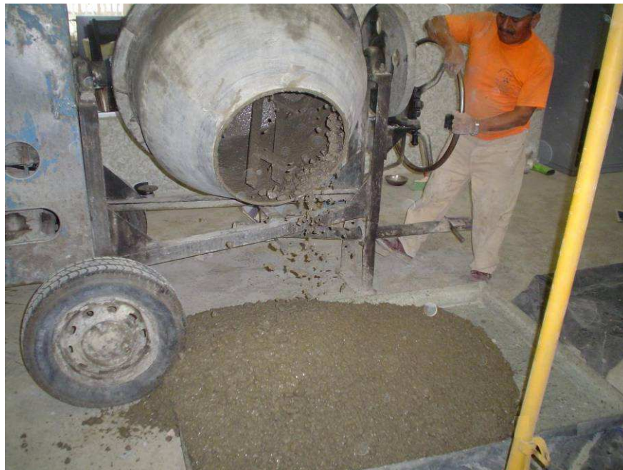
FIGURA 3.22 Hormigón para fundición vigas superiores.
