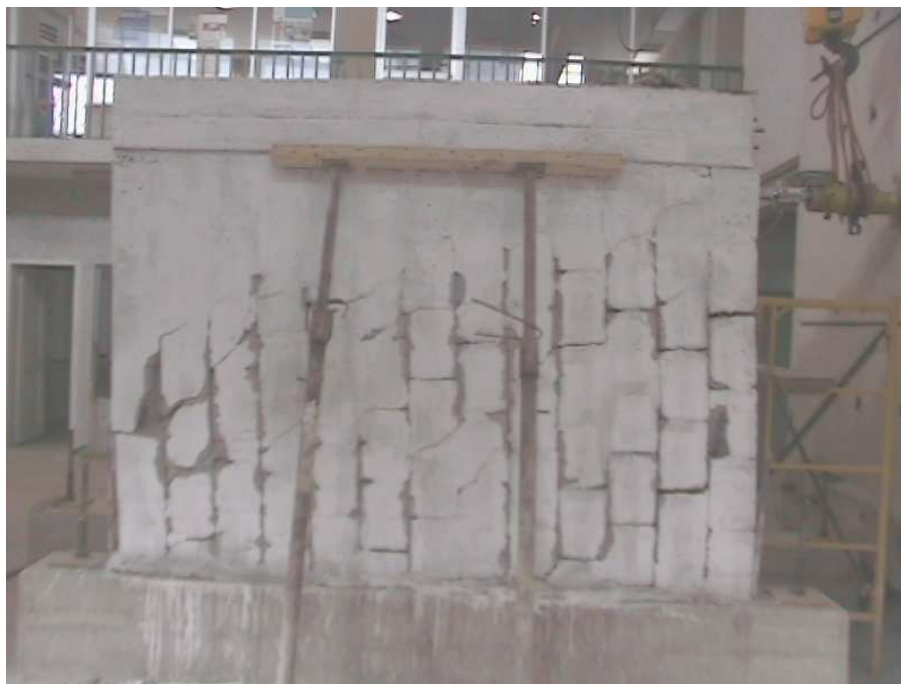
FIGURA 4.44 Pared sostenida con puntales lista para exploración y derrocamiento.
