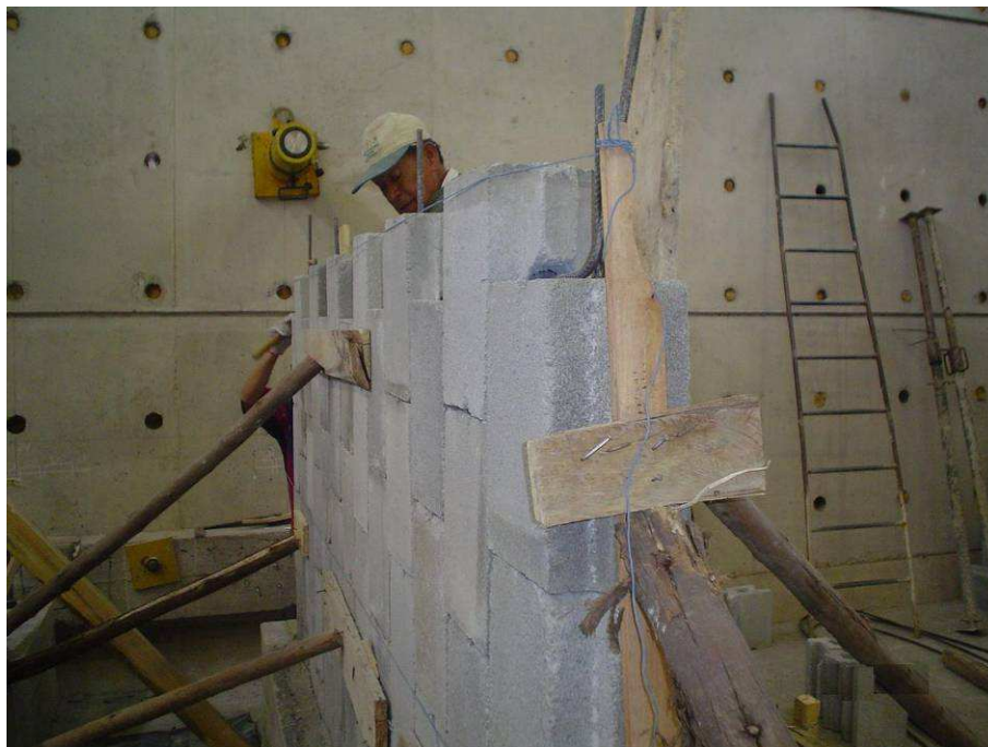
FIGURA 3.16 Estabilización y nivelación de pared con trabado vertical.
