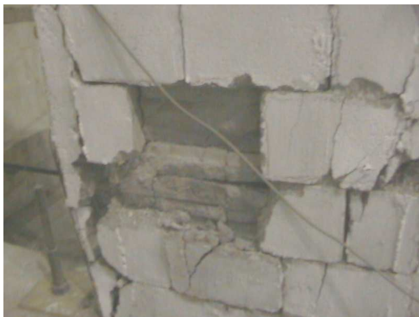
FIGURA 4.25 Penetración total de hormigón líquido en panel izquierdo.
