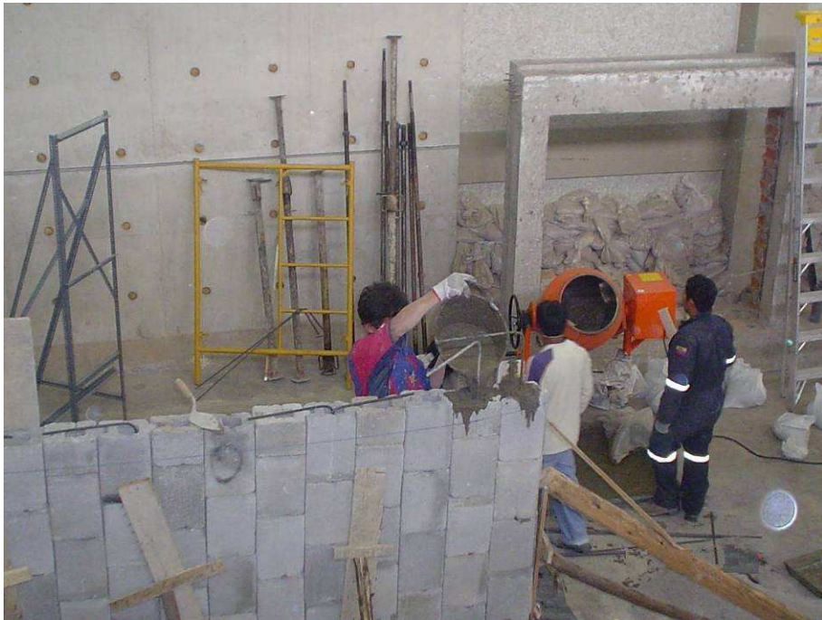
FIGURA 3.18 Fundición total de pared vertical.
