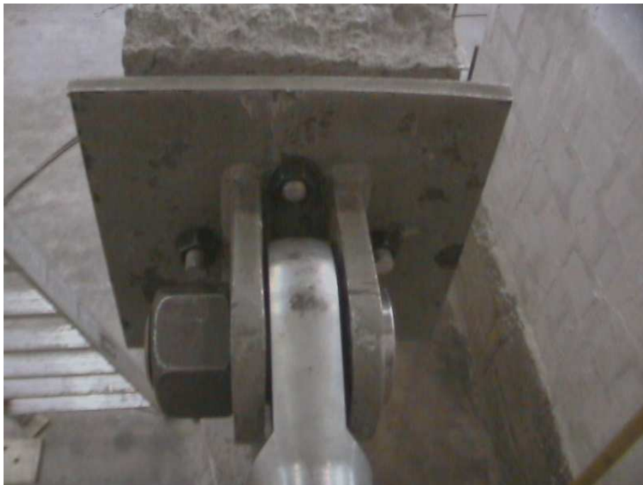
FIGURA 4.6 Ensamble de placa acoplada a la pared a ser ensayada
