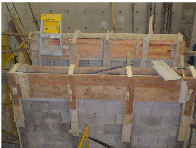
FIGURA 3.20 Encofrado de vigas superiores.
