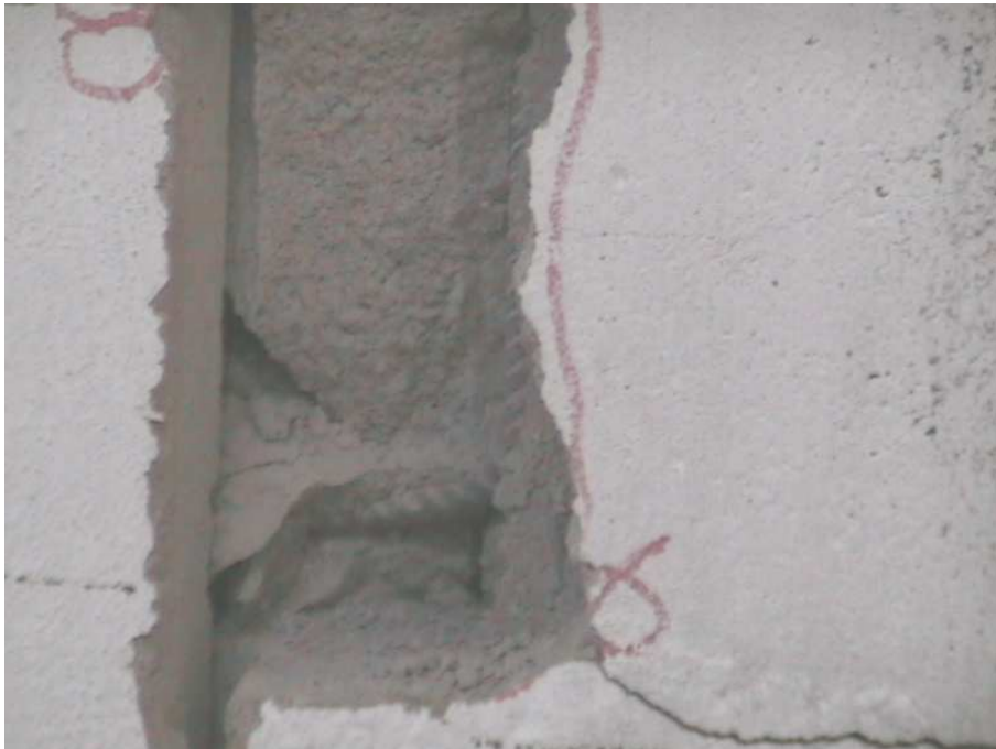
FIGURA 4.48 Mampuestos llenos de hormigón líquido.
