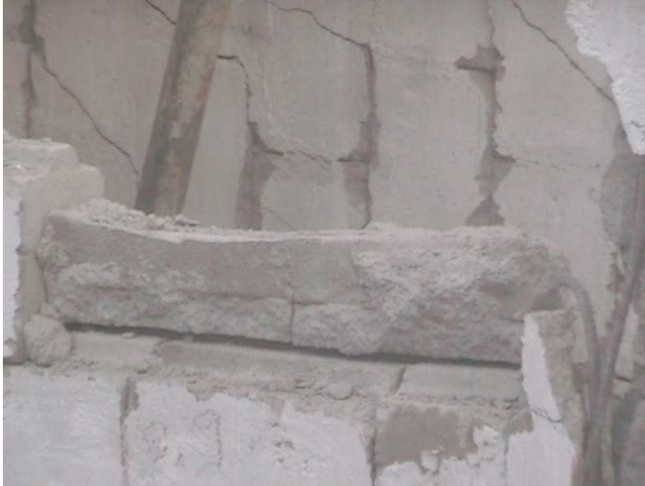
FIGURA 4.28 Recubrimiento del refuerzo horizontal panel derecho.
