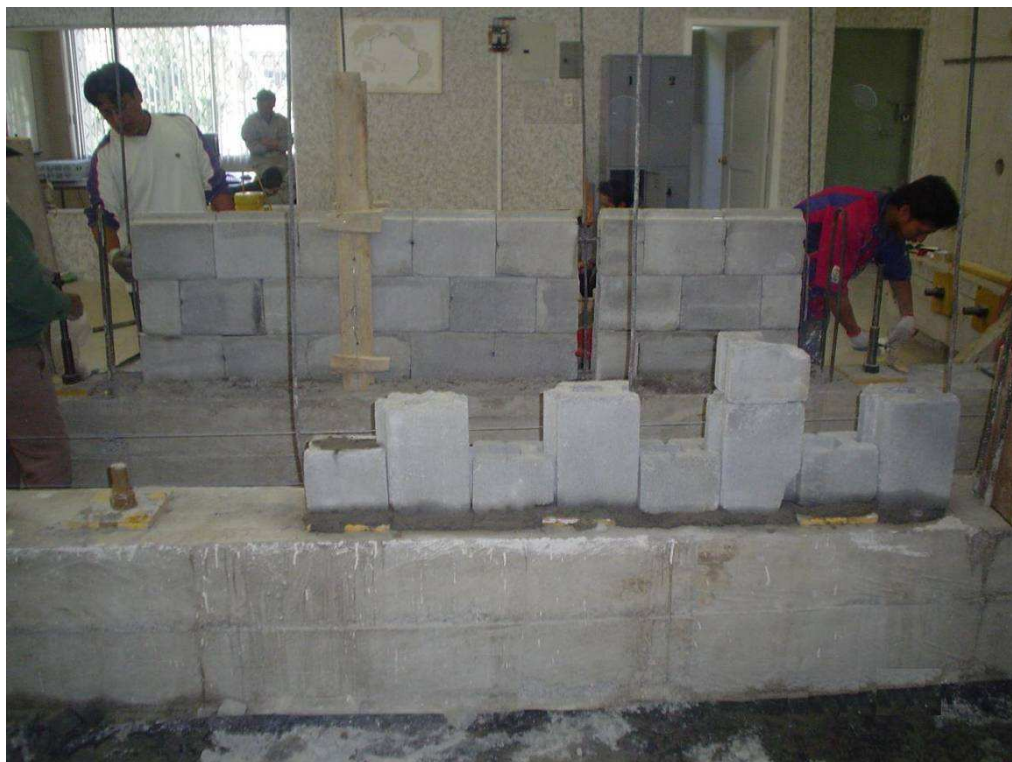
FIGURA 3.14 Colocación de fila maestra pared con trabado vertical.
