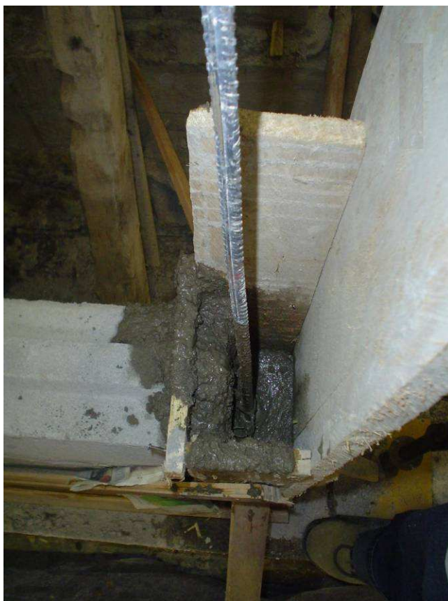
FIGURA 3.11 Vaciado del hormigón líquido
