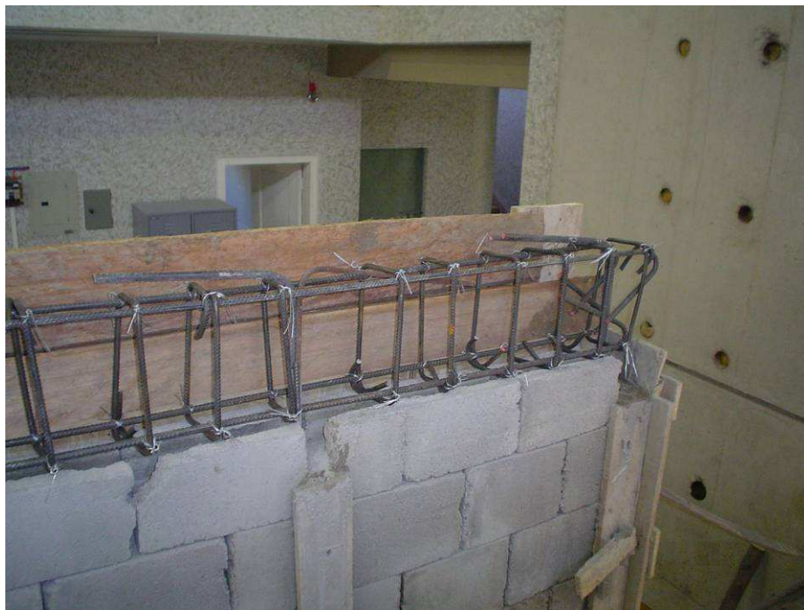
FIGURA 3.12 Encofrado final de columneta y refuerzo viga superior con el muro
