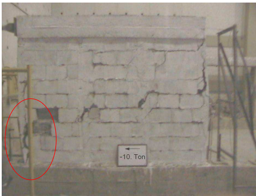
FIGURA 4.19 Fisuras finales de la pared (Terminación del Ensayo).
