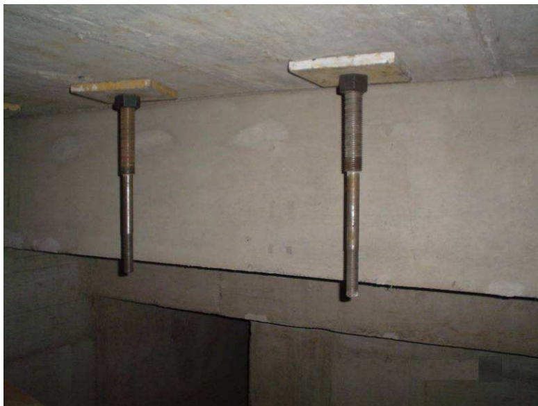
FIGURA 4.2 Pretensión de los ejes
