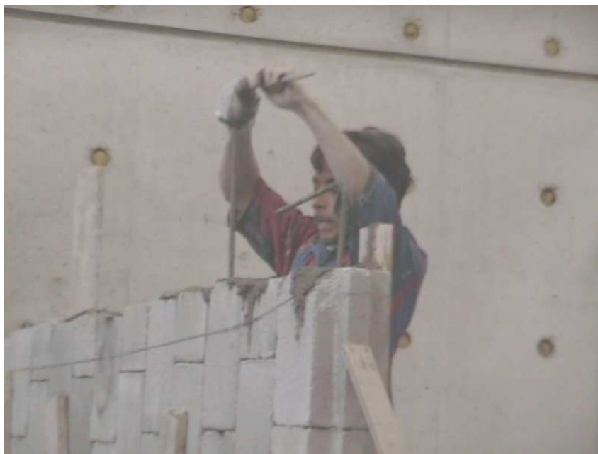
FIGURA 3.19 Distribución del hormigón con varilla.
