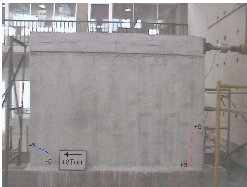
FIGURA 4.36 Pared aplicando 8 t de carga positiva, aparecen fisuras en la unión de bloques, no existen fallas de corte
