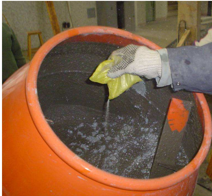
FIGURA 3.6 Mezcla del hormigón líquido
