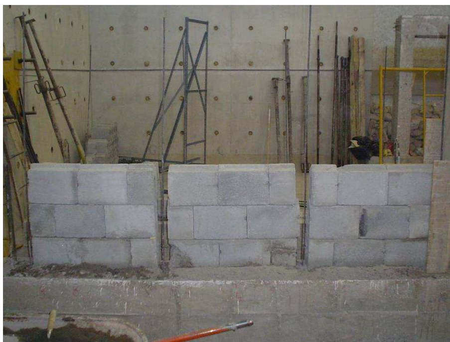
FIGURA 3.2 Primer tercio de pared con trabado horizontal
