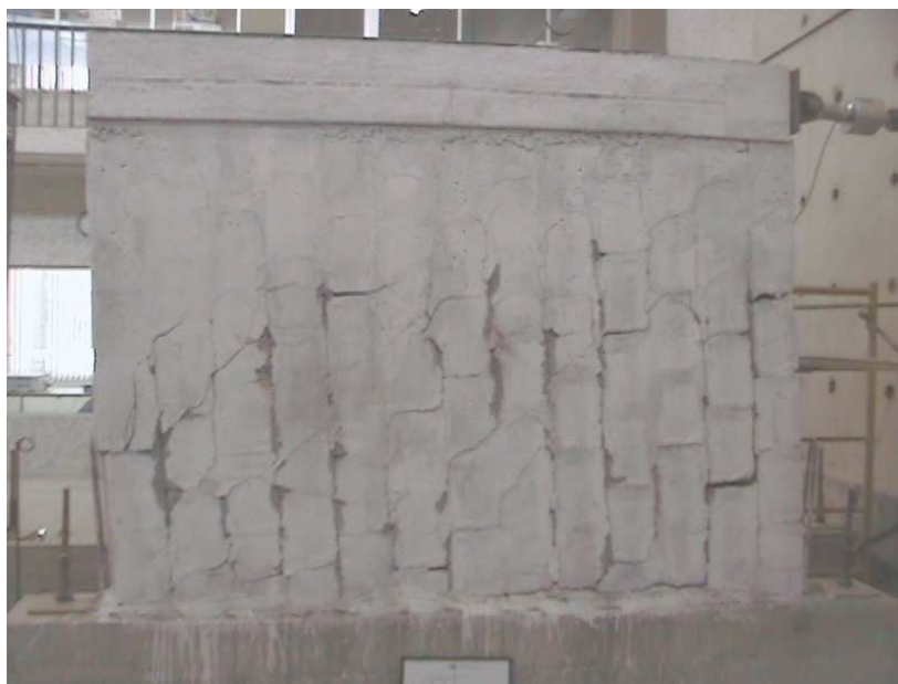
FIGURA 4.40 Fisuras finales de la pared (Terminación del Ensayo)
