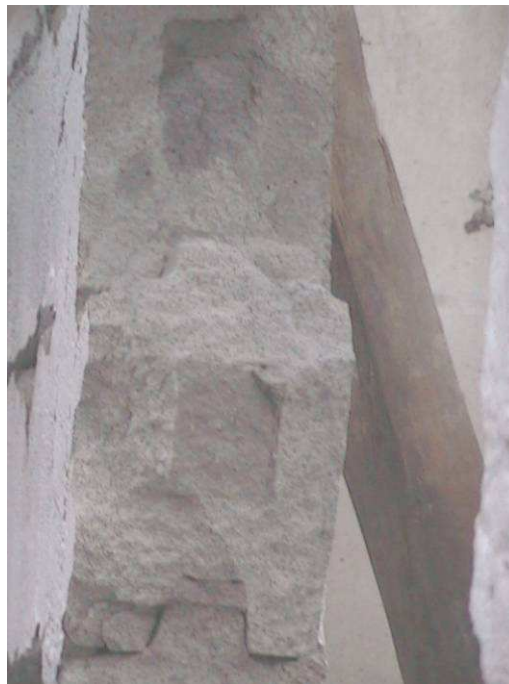
FIGURA 4.29 Penetración del hormigón líquido en su totalidad.
