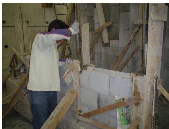
FIGURA 3.10 Fundición de 1/3 de mampostería
