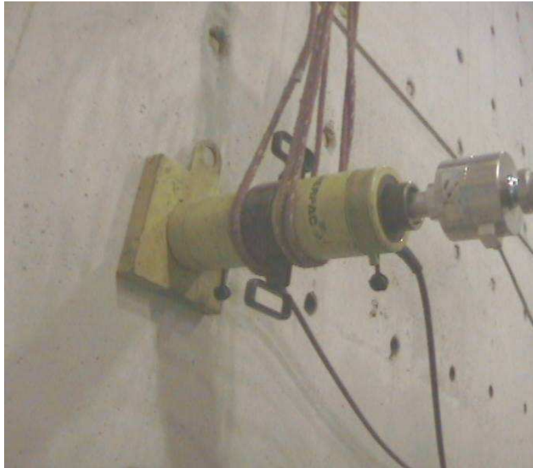
FIGURA 4.5 Instalación del Gato Hidráulico y Celda de Carga
