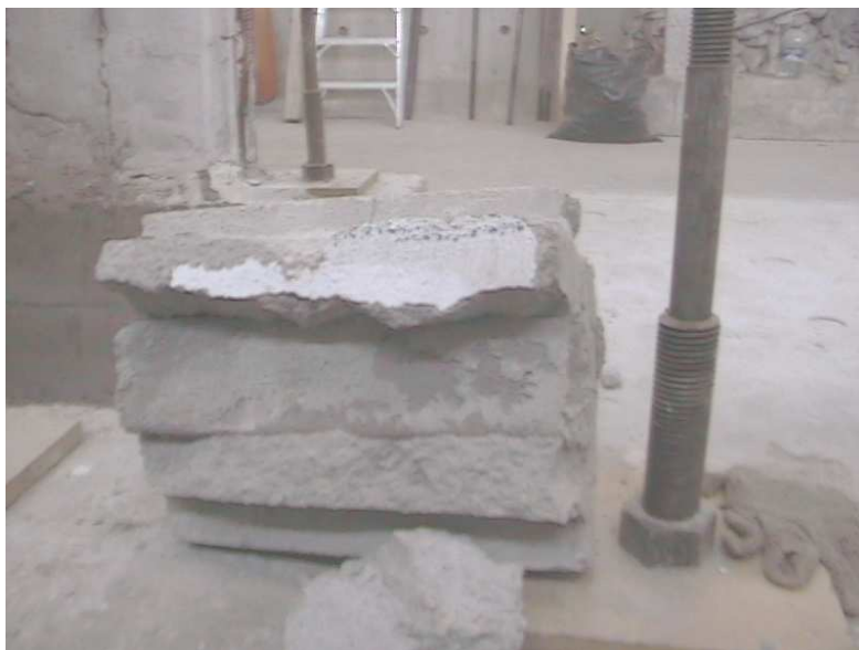
FIGURA 4.30 Mampuestos llenos de hormigón líquido.
