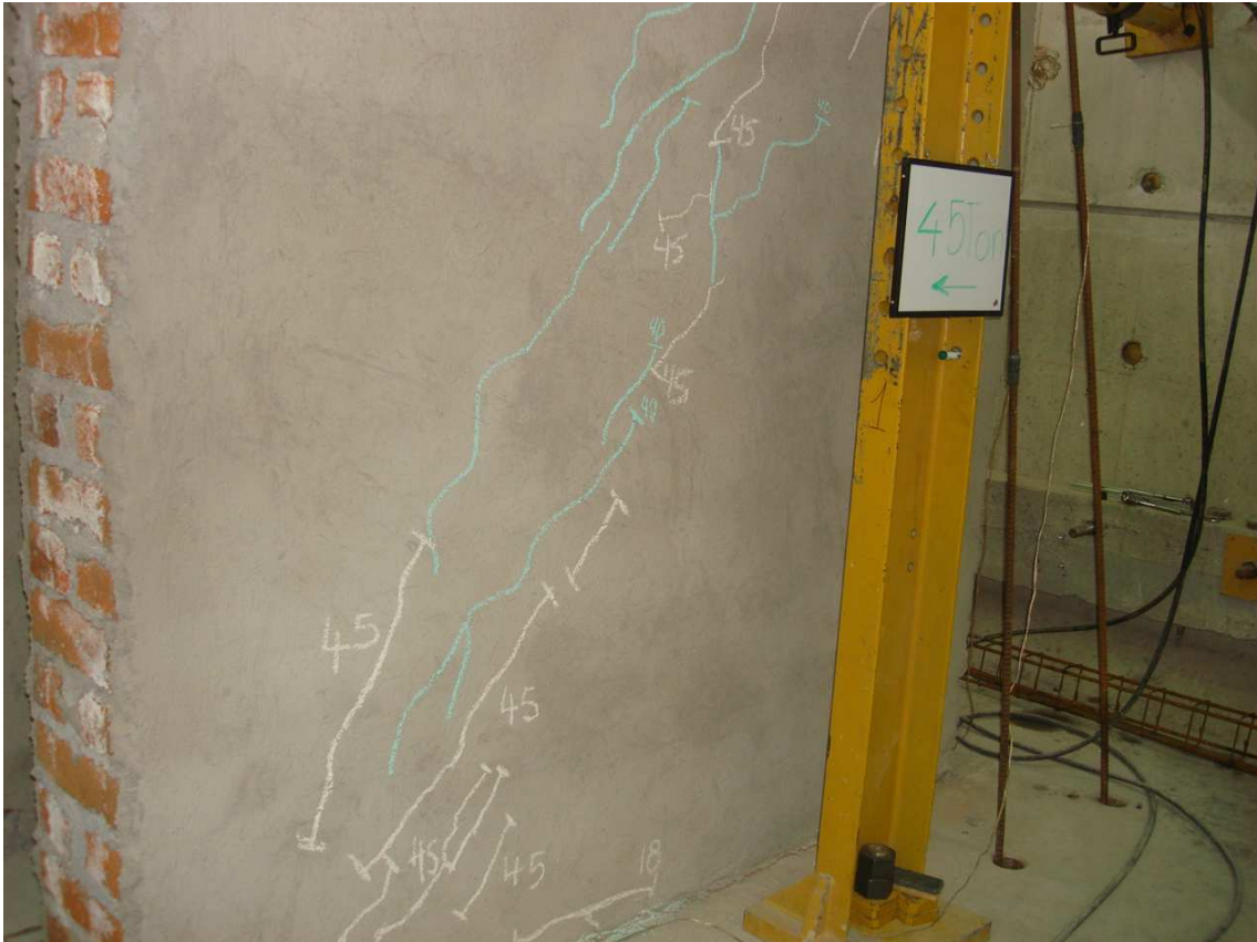
Fotografía 5.25: Fisuras en la pared a las 45 t de carga positiva
