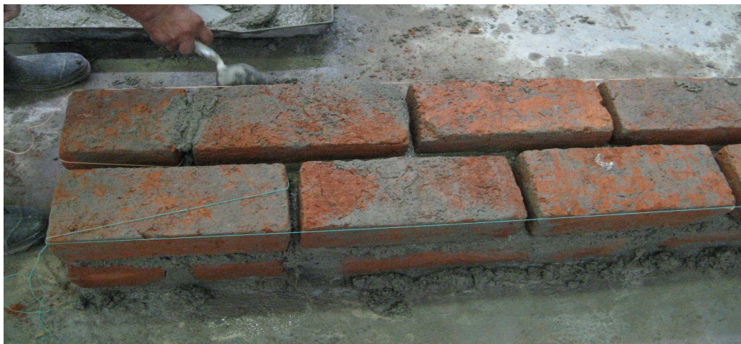
Fotografía 4.3: Disposición de ladrillos en la segunda hilada de la pared.
