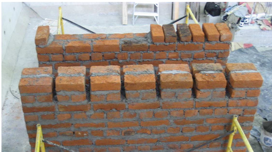
Fotografía 4.7: Paredes de mampostería previo a la fundición de la viga superior.
