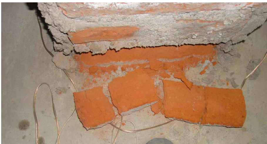
Fotografía 5.19: Desprendimiento de ladrillos una vez terminado el ensayo.
