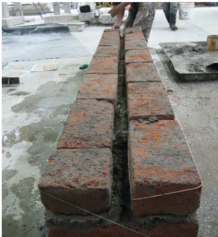
Fotografía 4.5: Vista lateral de una hilada concluida
