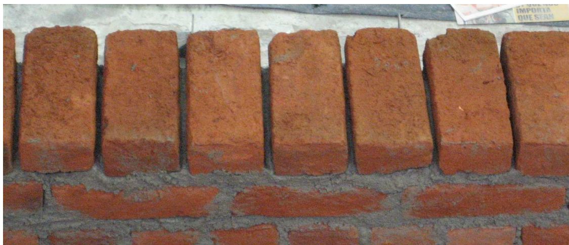
Fotografía 4.4: Disposición de ladrillos en la tercera hilada de la pared.
