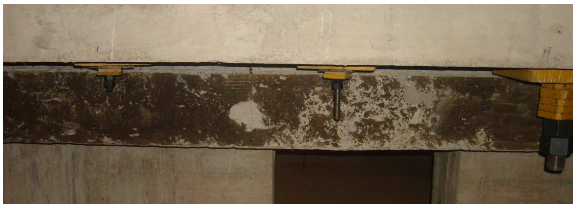
Fotografía 5.1: Empotramiento de tensores en la losa de reacción del laboratorio.
