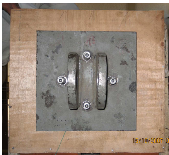
Fotografía 3.12: Placa de acero con 4 orificios colocada en la viga durante el proceso constructivo, se aprecia también las 4 varillas roscadas que sobresalen de la viga.
