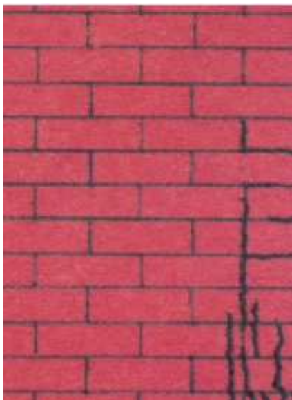
Figura 3.5: Falla por compresión en muros de mampostería.
