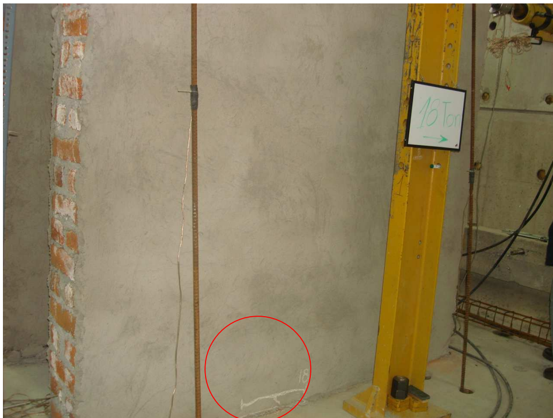
Fotografía 5.22: Fisura horizontal en la base de la pared a 18 t de carga negativa
