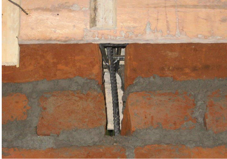
Fotografía 4.8: Refuerzo en los dientes de la viga superior \phi = 14 mm.
