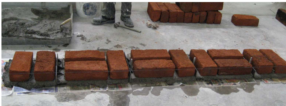
Fotografía 4.2: Disposición de los ladrillos en la primera hilada de la pared.
