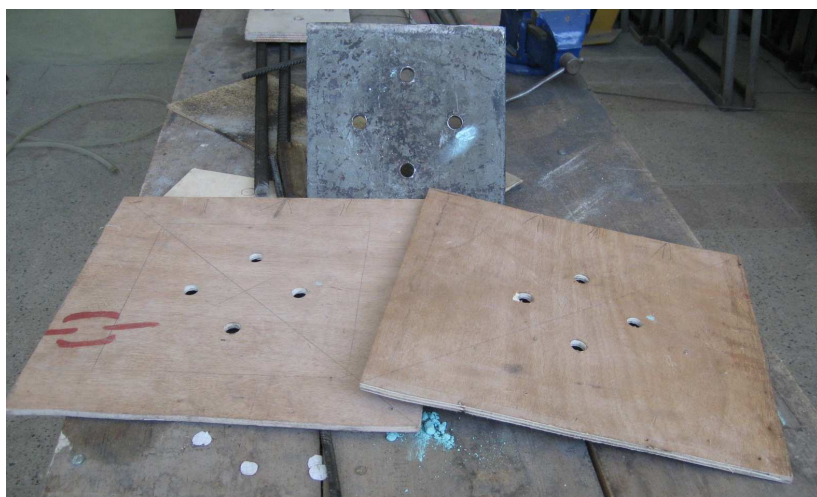
Fotografía 4.11: Construcción de paneles de madera para el encofrado de la viga, con 4 agujeros para las varillas \phi = 18 mm que irán conectadas al dispositivo transmisor de carga.
