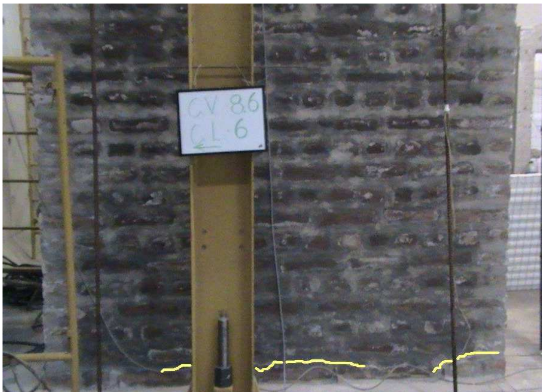
Fotografía 5.5: Fisuras en la pared a las 6 t de carga negativa
