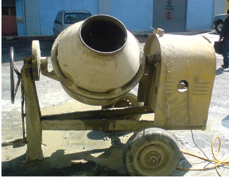
Fotografía 2.10: Concreteira para mezclar el hormigón.
