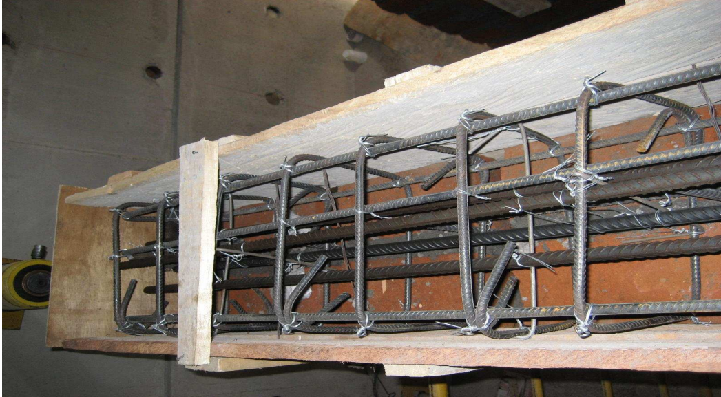
Fotografía 4.14: Viga lista para la fundición
