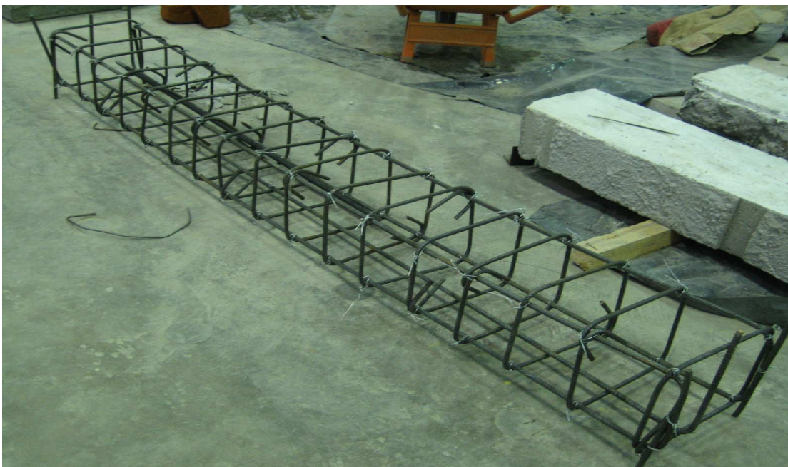
Fotografía 4.9: Detalle del armado de la viga superior.
