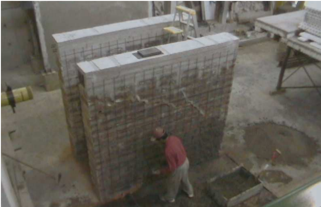
Fotografía 4.22: Paredes durante el proceso de colocación del enchape de reforzamiento.
