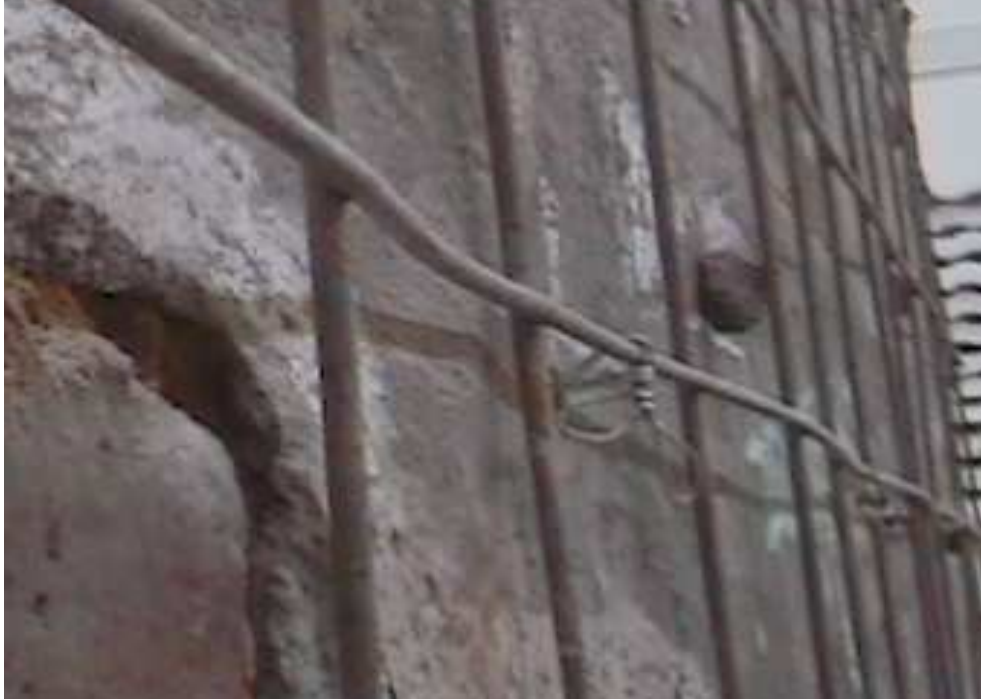
Fotografía 4.20: Amarre del alambre como vínculo de unión entre las mallas a cada cara de la pared.
