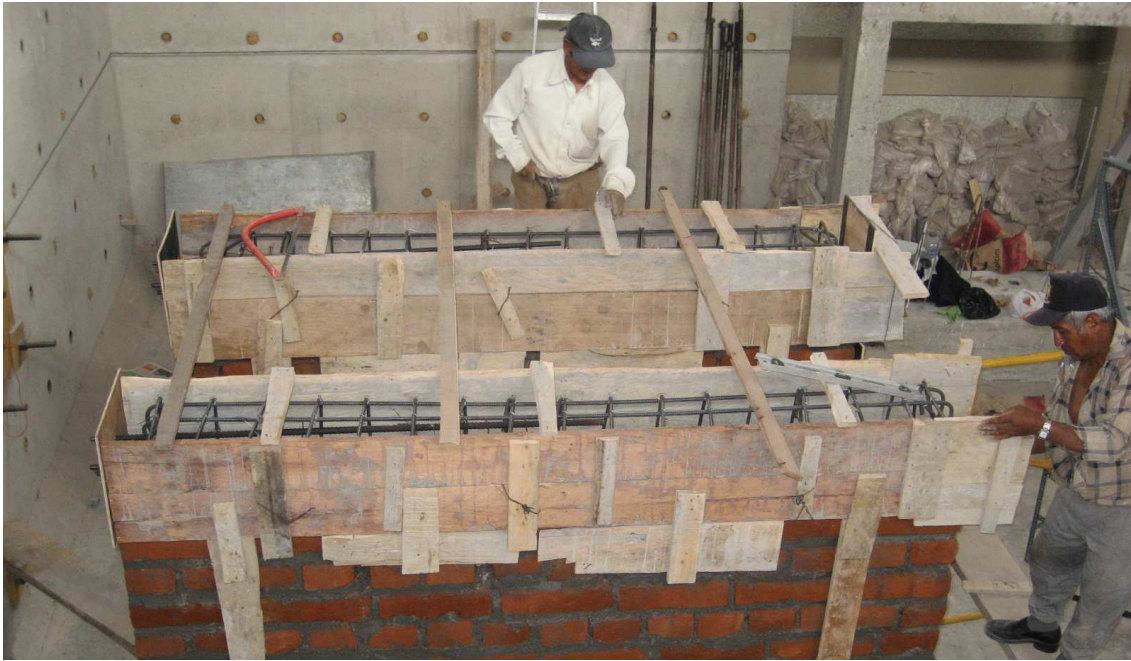
Fotografía 4.10: Detalle del encofrado de la viga superior.
