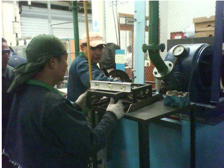
Figura 5.1. Nivelación de actuador.
