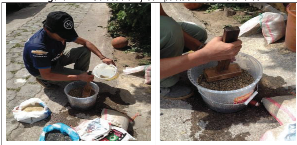
Figura 4-4.- Colocación y compactación de materiales.
