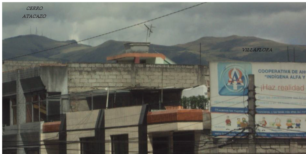
Figura 3.22 Línea de vista hacia el Cerro Atacazo
