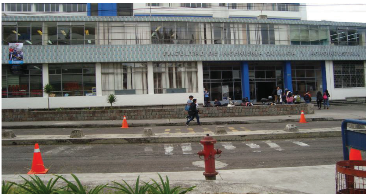
Figura 3.1. Hidrante situado frente al Edificio de Ingeniería Química
