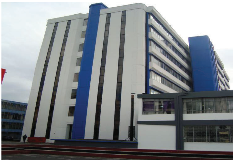
Figura 3.3. Fachada principal Edificio Química-Eléctrica
