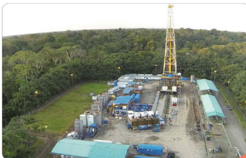
Figura 2.2. Plataforma levantada en el sitio del grupo de pozos.
