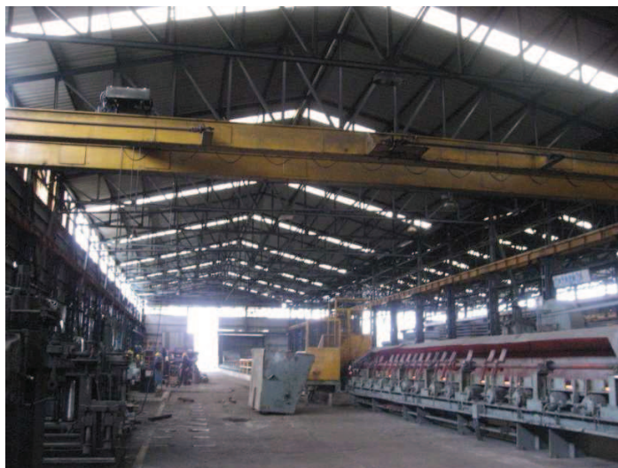
Figura 1.35 Puente Grúa de 15 Toneladas
