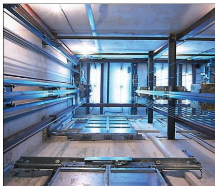
Figura 1. 4 Recinto o hueco de un ascensor
