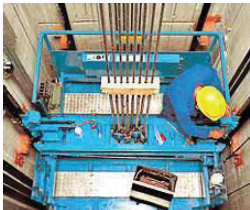
Figura 1. 10 Sistema de tracción por cables en ascensor
