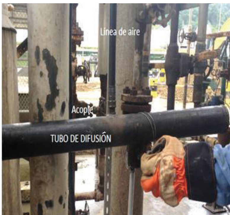
Figura 2.2 Muestreo de gases en la unidad Merox utilizando parrilla de difusión
