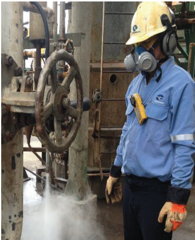
Figura 3.5 Muestreo en Merox utilizando parrilla de difusión
