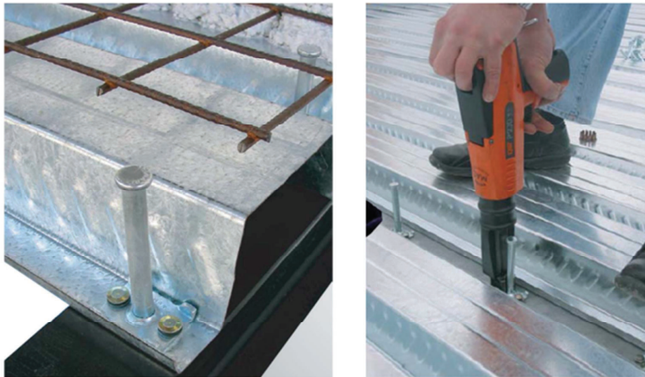
Imagen 11 Conectores tipo Perno fijado con clavos
