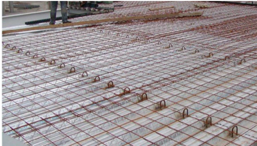
Imagen 13 Conectores tipo Barra doblada
