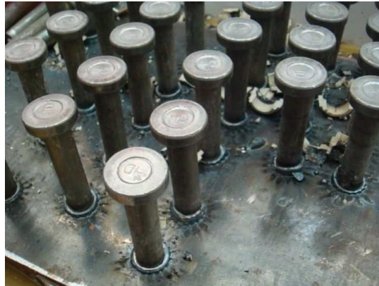
Imagen 7 Conectores tipo perno
