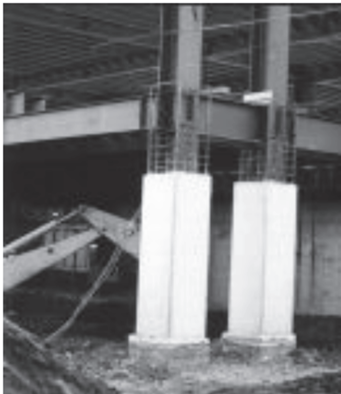
Imagen 2 Columnas Compuestas Ayuntamiento San José
