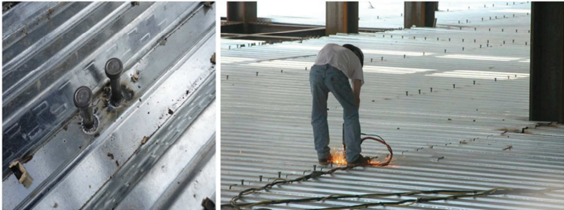
Imagen 8 Conectores tipo Espigo con cabeza
