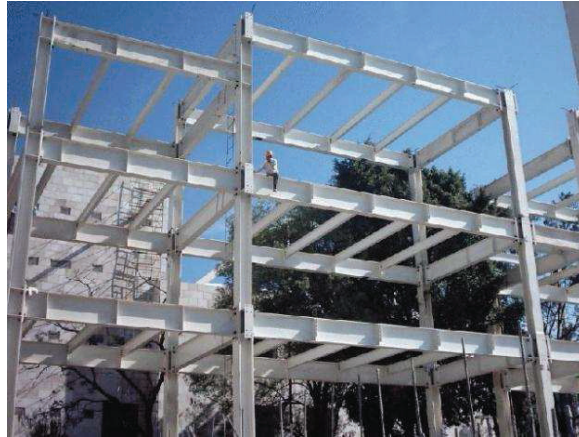
Imagen 5 Estructura en acero
