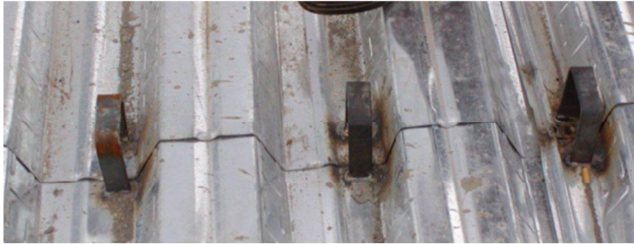
Imagen 14 Conectores tipo Platina doblada
