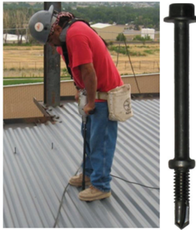
Imagen 12 Conectores tipo Tornillo auto perforante
