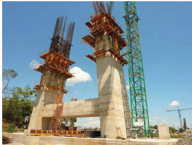
Imagen 4 Columnas reforzadas Puente Napo
