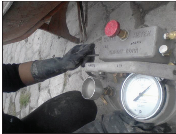
FIGURA 4.42 BOMBEO DE AIRE EN LA CÁMARA.
