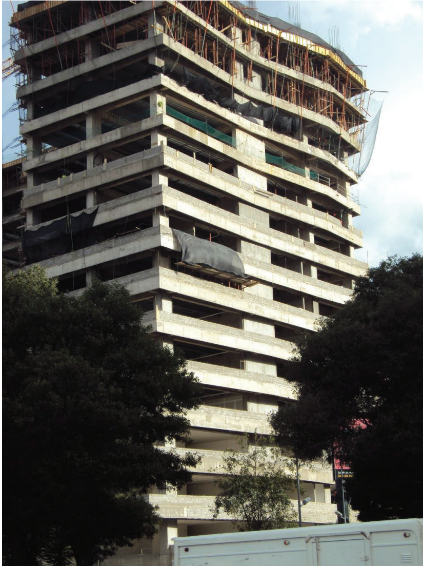
FIGURA1. 3 MURO DE CORTE DE CONCRETO (14 PISOS)
