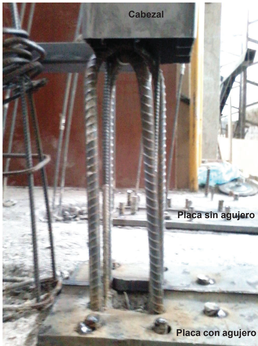
FIGURA 4. 5 PLACAS Y ANCLAJES
