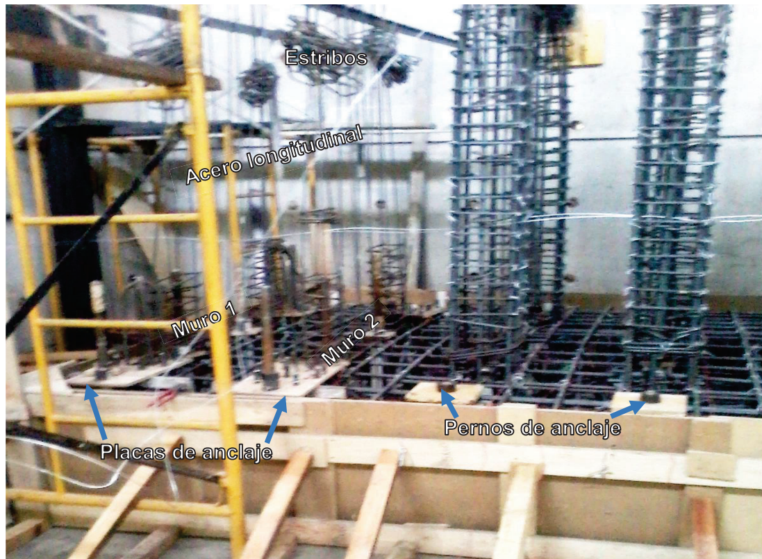
FIGURA 4. 4 LOSA DE CIMENTACIÓN
