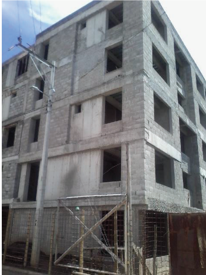
FIGURA1. 4 MURO DE CORTE DE CONCRETO (5 PISOS)
