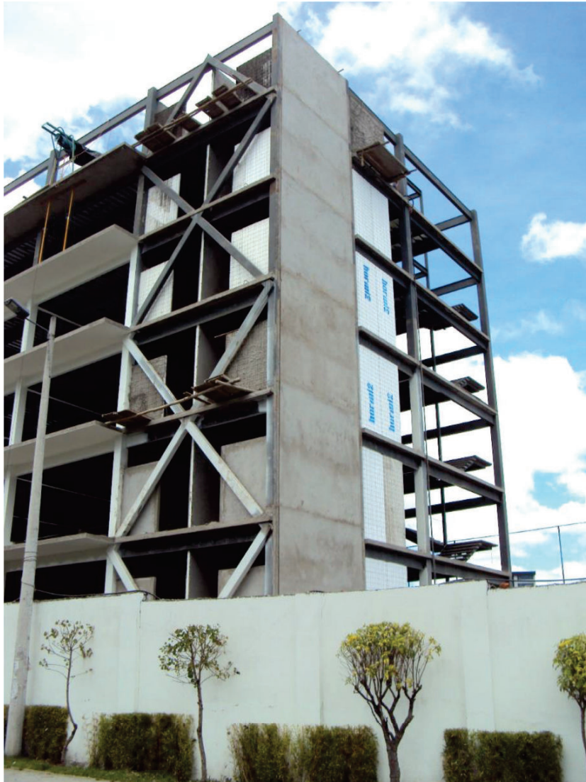
FIGURA1. 2 MURO DE CORTE MIXTO ACERO-CONCRETO CONSTRUIDO
