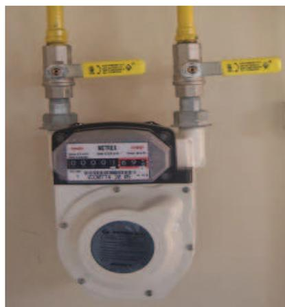
Figura 4.6 Gasómetro
