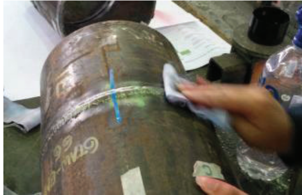
Fotografía 6. 17 Limpieza de la soldadura de la tubería a analizar, esto se puede realizar con un solvente (thinner), con la ayuda de un paño seco.
