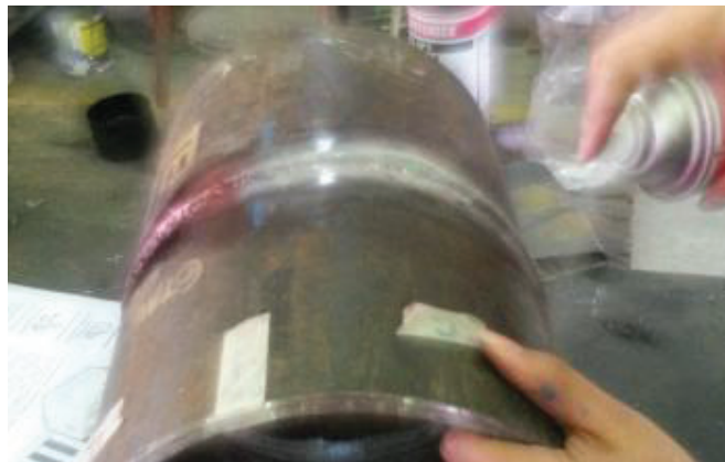
Fotografía 6. 20 Aplicación del revelador, El revelador marca: Spotcheck SKD-S2. El revelador tipo húmedo no acuoso en spray.
