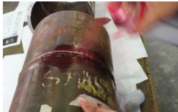
Fotografía 6. 18 Aplicación del líquido penetrante marca: Spotcheck SKL-SP2 en spray, en toda la longitud de la soldadura, tiempo de permanencia de 10 minutos.
