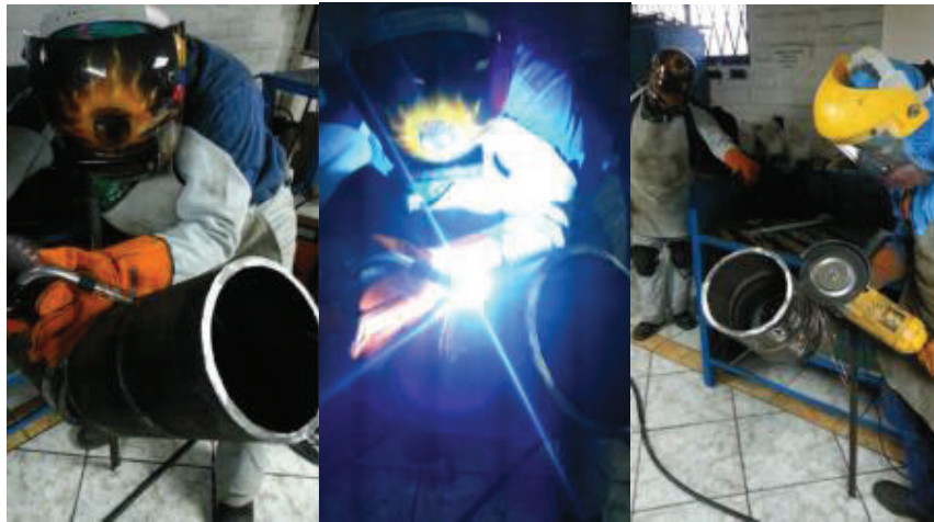
Fotografía 6. 7 Soldadura y limpieza proceso GMAW con Pulse Fuente: Propia.
