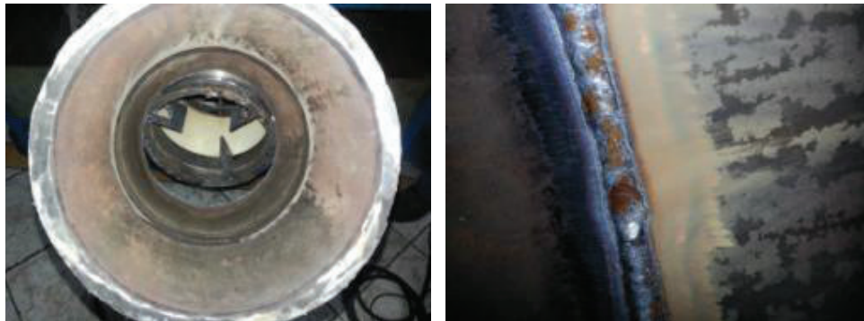
Fotografía 6. 5 Muestra de soldadura de pase de raíz bajo proceso GTAW en posición 6G. Presenta buena penetración y uniformidad.
