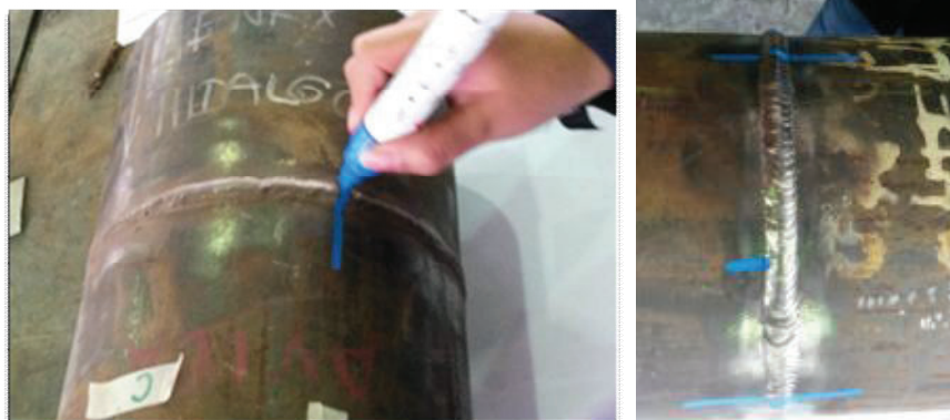
Fotografía 6. 16 Identificación de la sección de cada tubería que se va realizar el ensayo.
