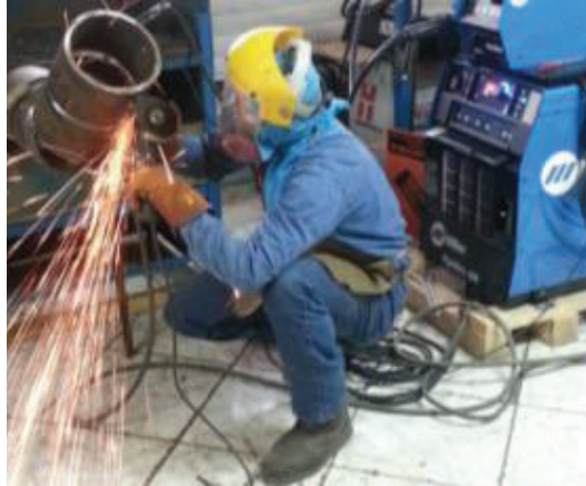
Fotografía 6. 9 Proceso de limpieza de la soldadura utilizando amoladora, la limpieza se realiza después de realizar cada pase de soldadura.
