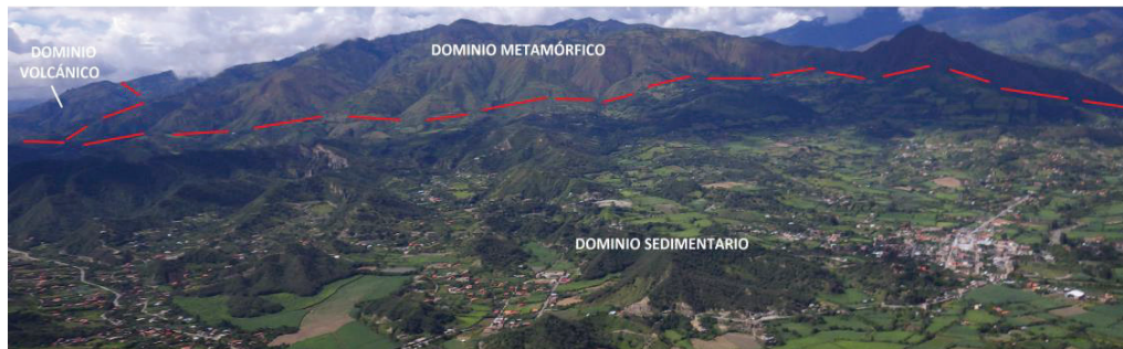
Figura 4.4 Panorámica de los dominios morfoestructurales Vista hacia el NE desde Cerro Minas (UTM: 691206 / 9531391)
