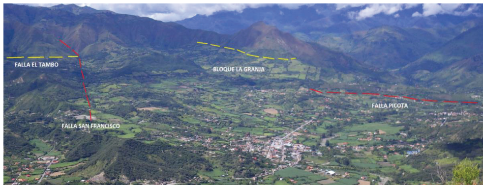
Figura 4.11 Panorámica del Bloque “La Granja” Vista hacia el NE desde Cerro Minas (UTM: 691206 / 9531391)
