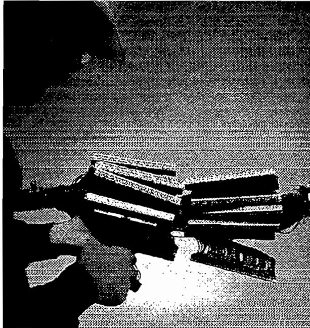
**Figura 2.68** Empalme con Módulos de Conexión.
