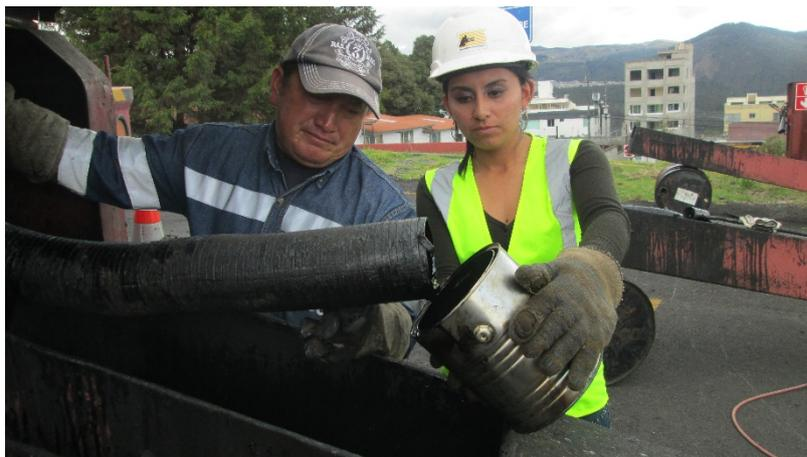
Fotografía 3.3 Muestreo in situ del cemento asfáltico
