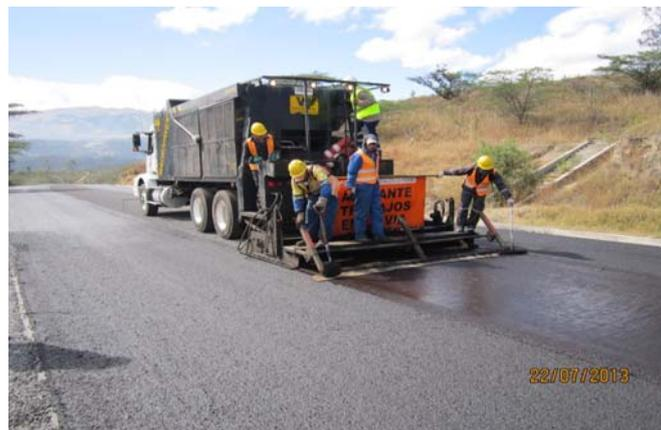
Fotografía 1.4 Planta de asfalto móvil para mezclas en sitio<sup>27</sup>
