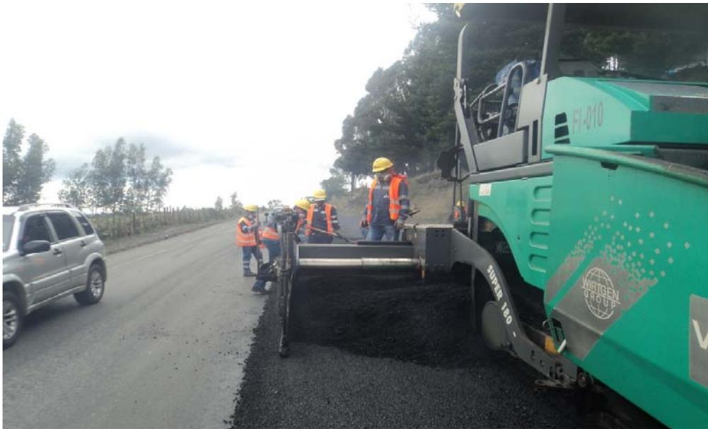
Fotografía 4.4 Extendido de la Mezcla Asfáltica
