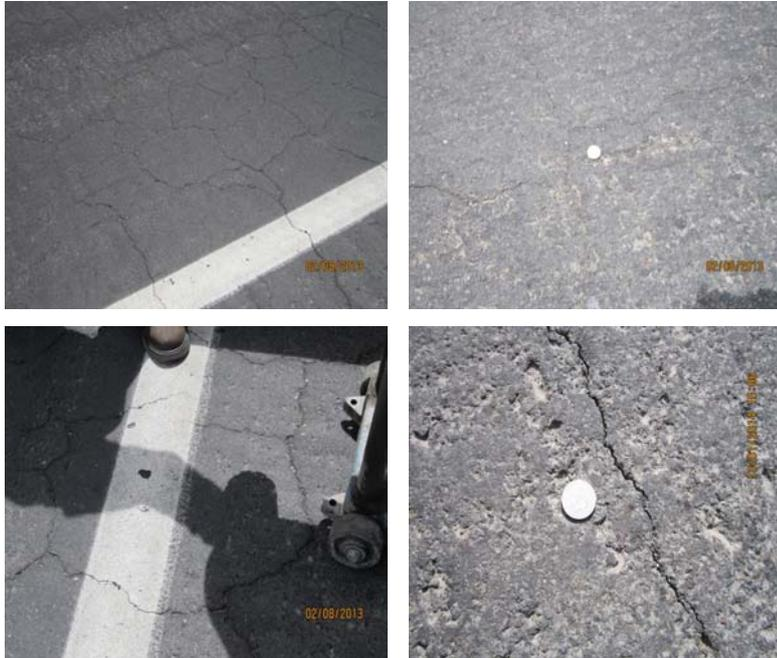
Fotografías 1.5 Agrietamiento y fisuras en pavimentos asfálticos<sup>28</sup>
